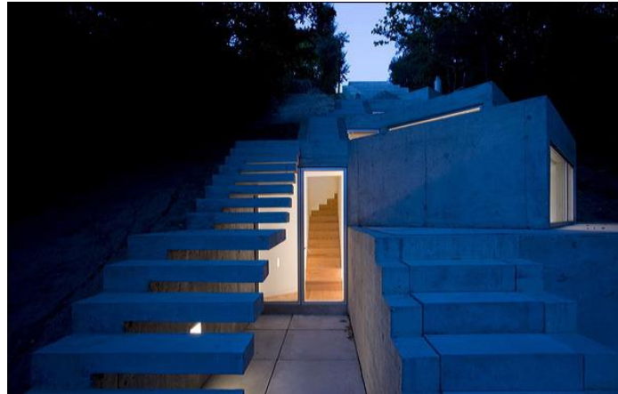
Figura 51 - Casa Toló. A casa é contruída ao longo da encosta.
