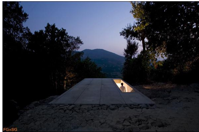
Figura 50 - Casa Toló, Álvaro Leite Siza, Vila Real. Entrada feita pela cobertura.
