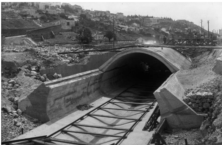
Figura 6 - Obras de construção do caneiro de Alcântara. Autor desconhecido
