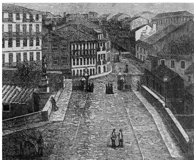
Figura 2 - Pormenor dos portões que condicionavam o acesso à cidade de Lisboa na ponte de Alcântara em meados do séc. XIX (arq.AML)
