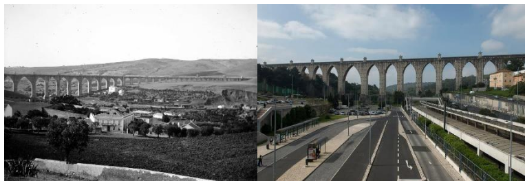
Figura 9 e 10 - Vale de Alcântara. Antigamente Visto de Campolide (autor: Paulo Guedes, à esquerda) e Vale de Alcântara atualmente (autor desconhecido, à direita).
