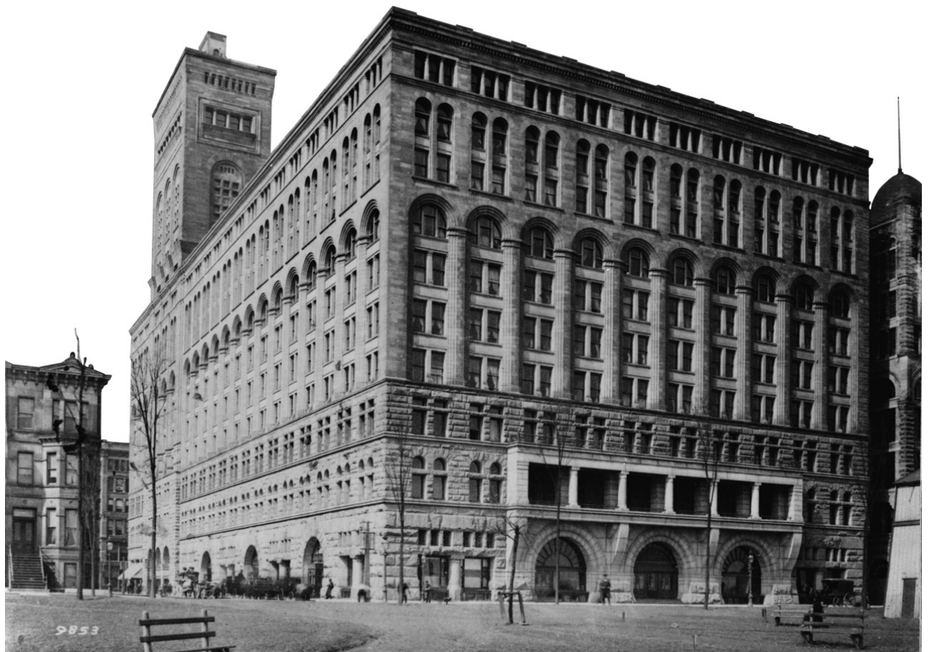
Fig 17. Fotografia do Auditorium Building, adaptada pelo autor
