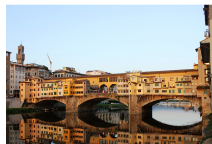
Fig 4. Ponte Vecchio, Florença
