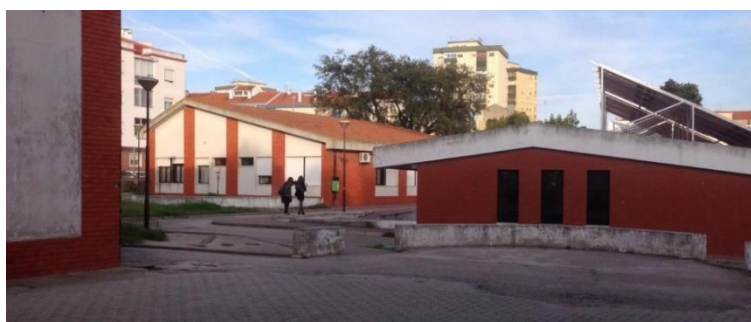
Figura 7: Vista do Refeitório e do Edifício Administrativo (Fonte Própria)
