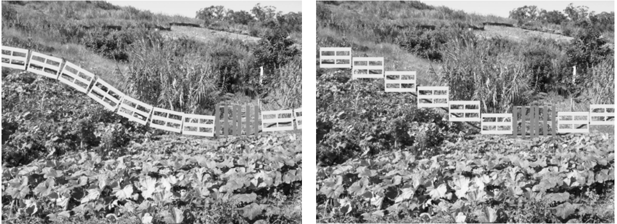
Figura 41 e Figura 42 – Dois modos de articulação das paletes para construção das vedações das Unidades Hortofrutícolas
