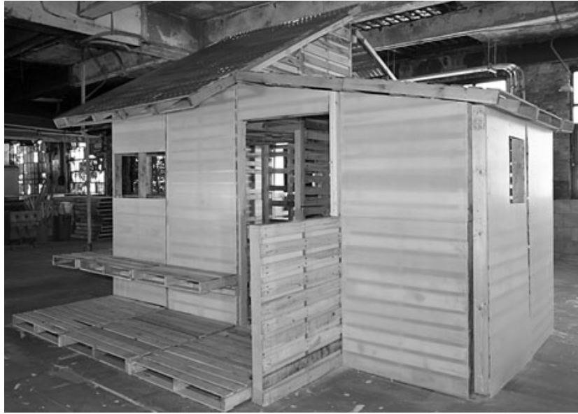
Figura 45 – A construção com paletes de madeira
