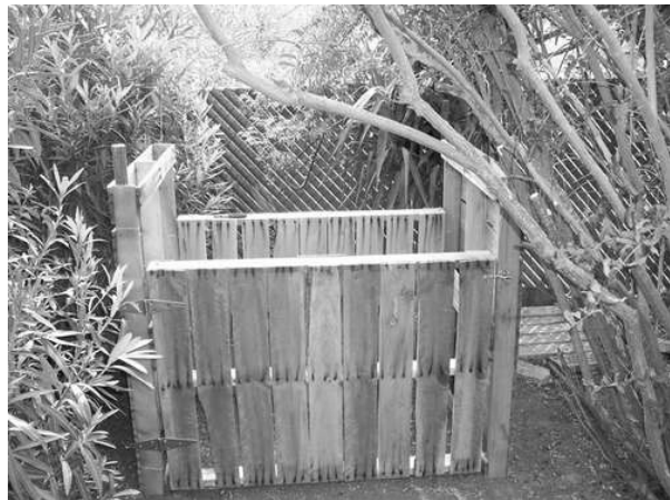
Figura 43 e Figura 44 – Banco e unidade de compostagem construídos com paletes de madeira
