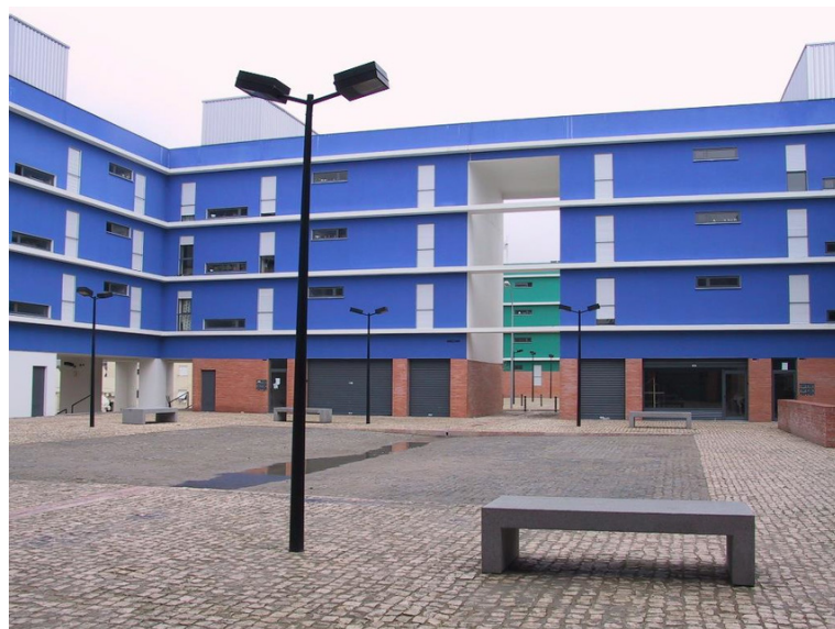
133 | O espaço comum, Travessa Sargento Abílio, 1999-2001, arquiteto Paulo Tormenta Pinto
