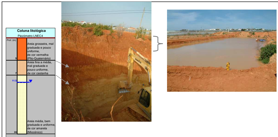
Figura 5.3 – Coluna litológica do piezómetro LNEC4 e sua relação com o perfil vertical dos estratos litológicos na zona não saturada, no Areal Gordo. Pormenor da bacia de infiltração nas areias vermelhas (Lobo Ferreira et al. , 2007b)
