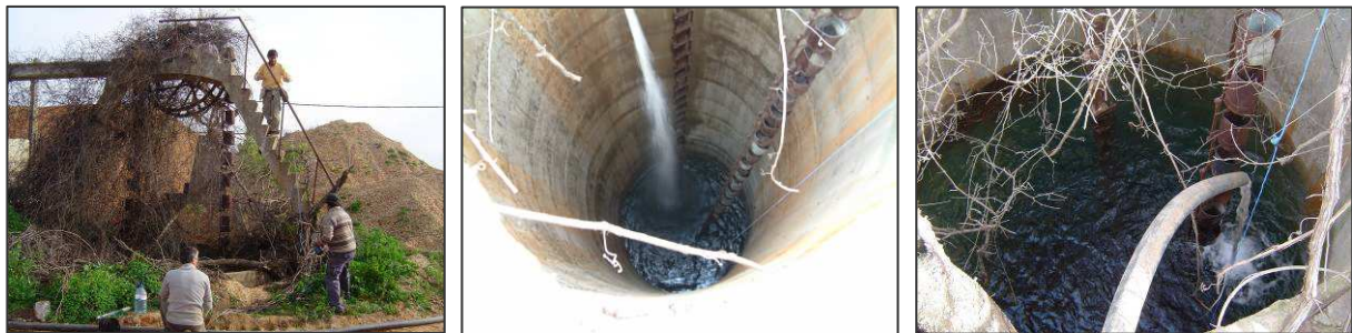
Figura 5.22 – Algumas fotografias do poço de grande diâmetro, onde foi realizado o ensaio de injeção, durante instalação do equipamento de monitorização, no início do ensaio e quando o nível piezométrico estabilizou muito próximo da superfície, no final do 3º ensaio (Lobo Ferreira et al., 2007b)
