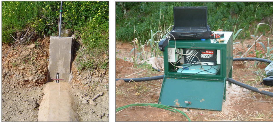
Figura 5.32 – Sensor de medição do nível de água instalado no leito do rio Seco, respectiva secção transversal e equipamento de registado contínuo de dados.
