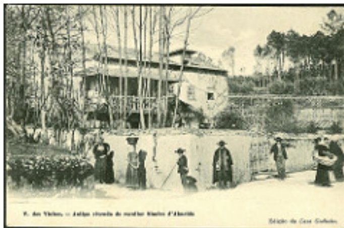
Figura 9: Antiga vivenda de Simões de Almeida. Biblioteca Municipal de Figueiró dos Vinhos. Autor desconhecido. Foto: https://www.flickr.com/photos/bmfigueirodosvinhos/with/3458587829/
