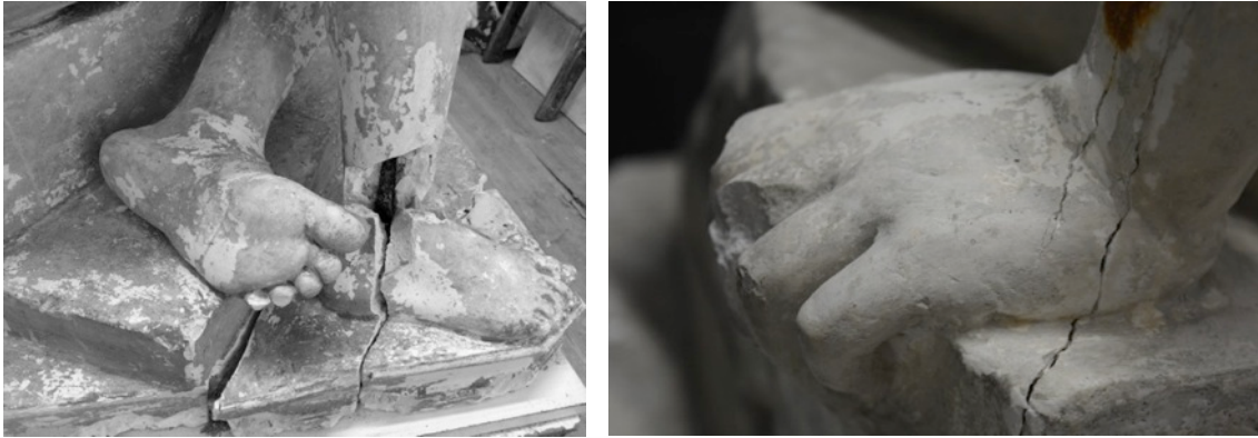
Figura 52: Detalhe de lacuna no pé com oxidação do ferro e Detalhe de fissura da mão esquerda. Fotos: Miguel Matos.
