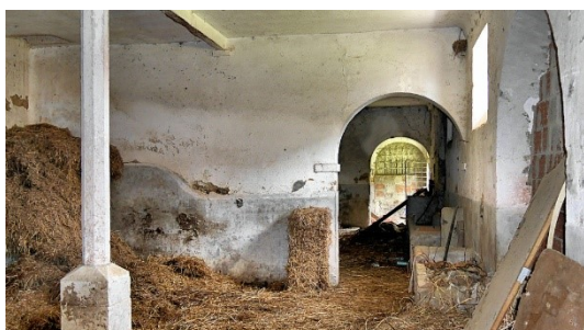
[fig.30] a [fig.36] Vistas interiores dos antigos armazéns agrícolas e pecuários
