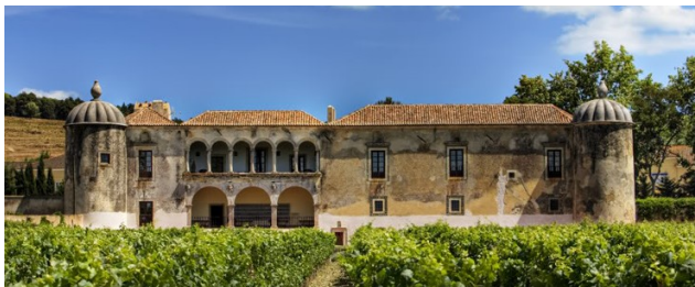
[fig.38] Fachada Poente do Palácio da Bacalhoa,2015.
