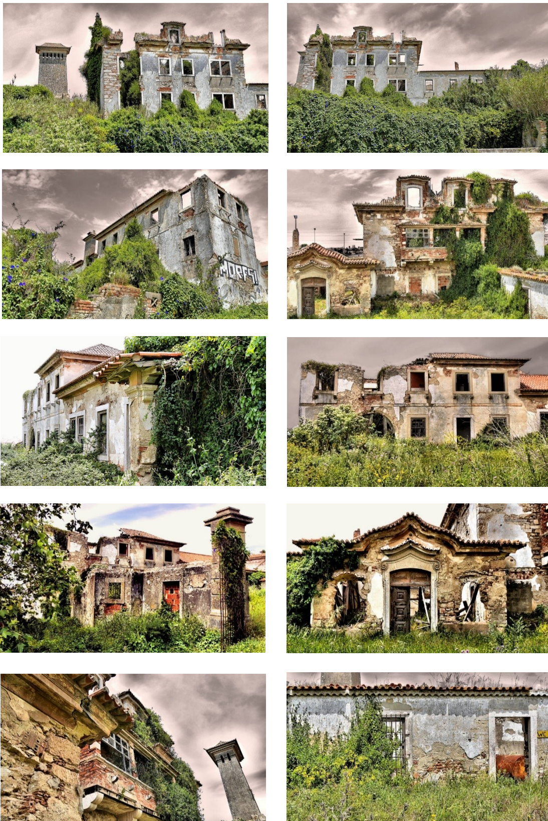
[fig.20|a] fig.29| Vistas exteriores da Quinta da Torre d' Aguilha
