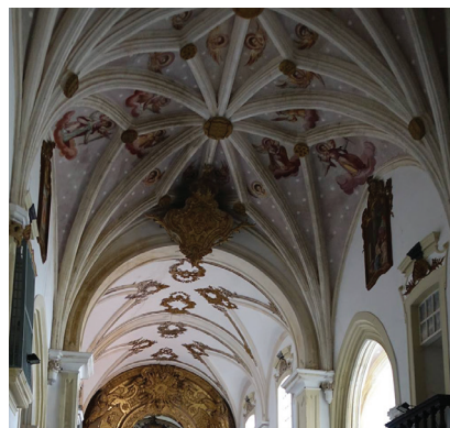
Figura 67. Representação 3D e 2D Complementada com fotografia das abóbadas da Igreja de SBC Fonte: Autor
