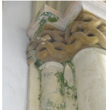
Figura 82. Desenvolvimento de vegetação devido à humidade Fonte: Autor
