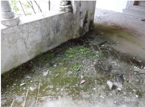
Figura 81. Desenvolvimento de vegetação devido à humidade Fonte: Autor
