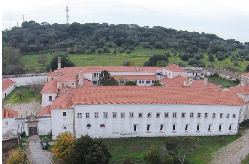
Figura 58. Fachada do Mosteiro de SBC, Alcado Nascente Fonte: Autor
