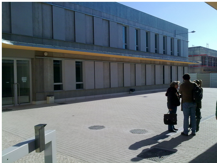
Figura 12. Escola Secundária Quinta do Marquês. Nova entrada de acesso após as obras. Vista para o Pavilhão das Artes. Fonte: própria.
