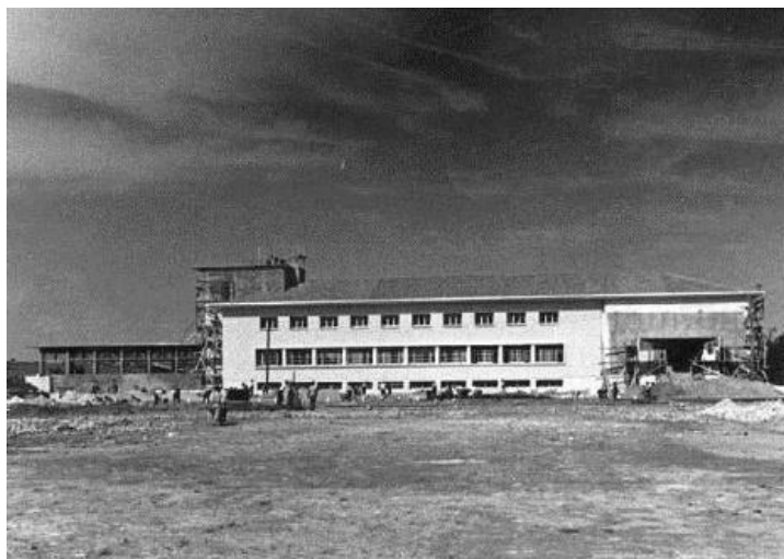
Figura 2 - Construção da Gare do Aeroporto (1939). Fonte: https://restosdecoleccion.blogspot.com/2009/10/aeroporto-de-lisboa-em-construcao.html
