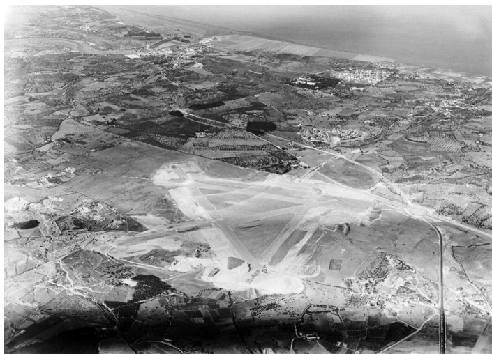
Figura 1 - Terraplanagem e Construção das Pistas do Aeroporto (1939). Fonte: https://restosdecoleccion.blogspot.com/2009/10/aeroporto-de-lisboa-em-construcao.html
