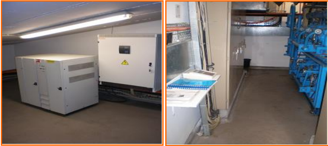
Figura 8: Áreas técnicas limpas e inspeccionadas
