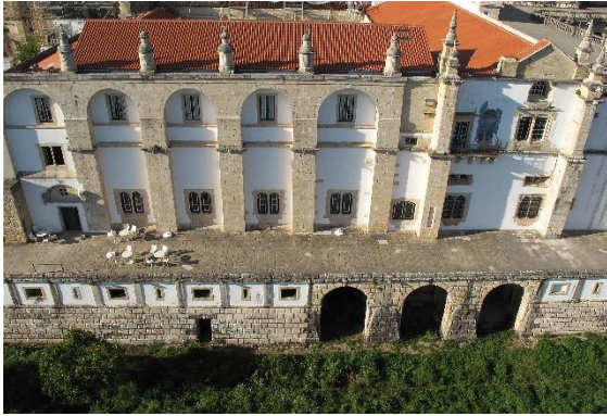
Figura 99- Fotografia aérea do Convento de Cristo. Fonte: ArchC_3D
