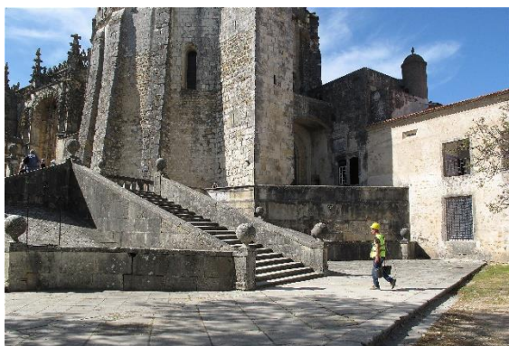
Figura 110- Fotografia das escadas principais. Fonte: ArchC_3D
