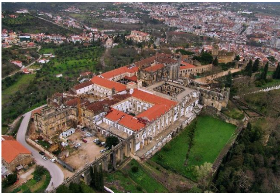
Figura 78- Fotografia aérea do Convento de Cristo. Fonte: ArchC_3D
