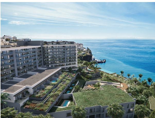
Figura 3 – Visualização 3D da fachada exterior do edifício Fonte: Website Madeira Acqua
