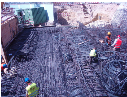
Figura 11 – ferro aplicado na execução da laje
