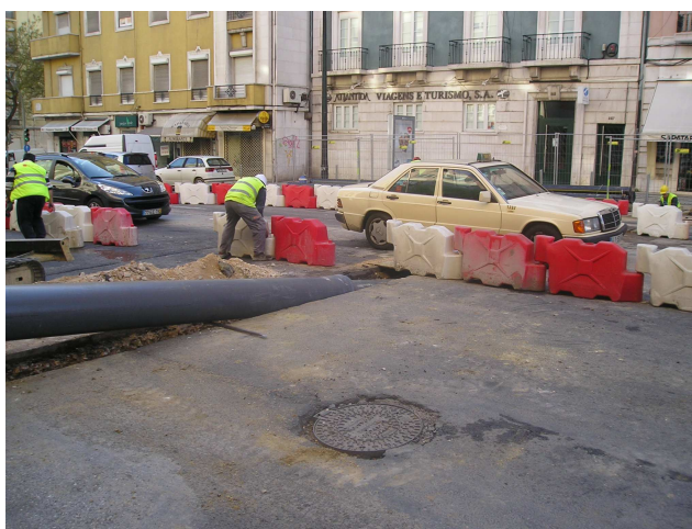
Figura 2 – Actividade de desvio de infra-estruturas
