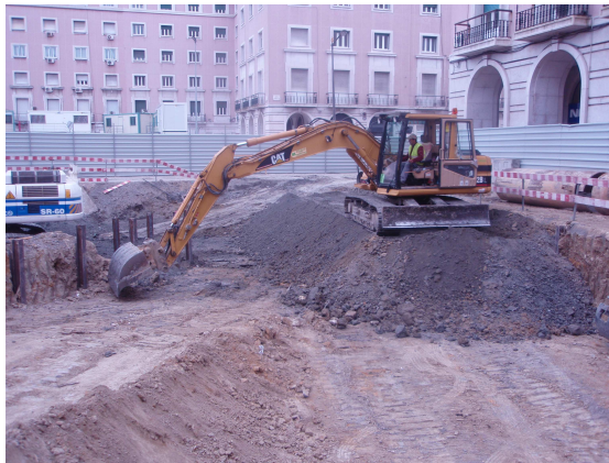
Figura 9 – início da actividade de escavação
