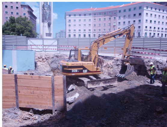
Figura 10 – continuação da actividade de escavação
