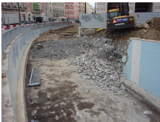
Figura 7 – Demolição parcial de um muro
