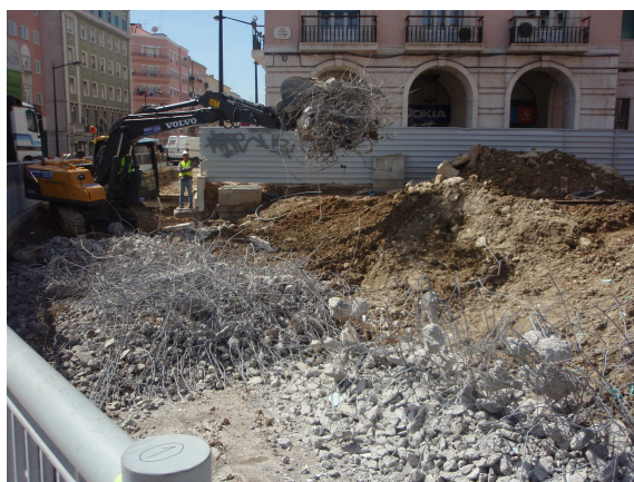
Figura 8 – Demolição total do muro
