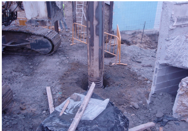
Figura 3 – Furação do terreno para execução da estaca
