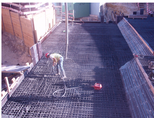
Figura 12 – betonagem da laje
