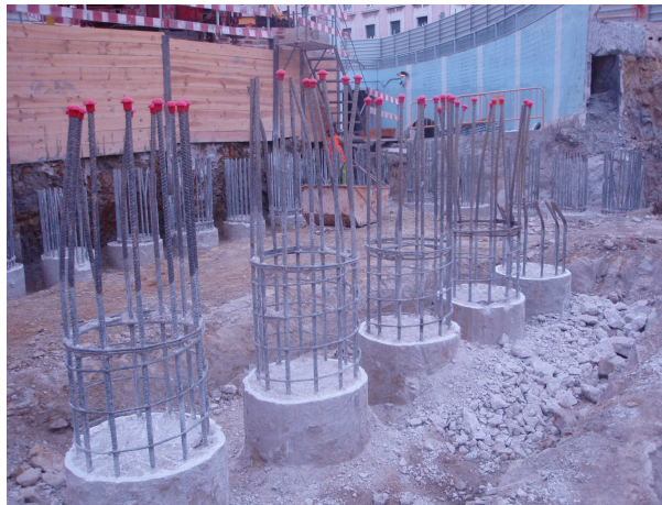
Figura 4 – Estacas já betonadas
