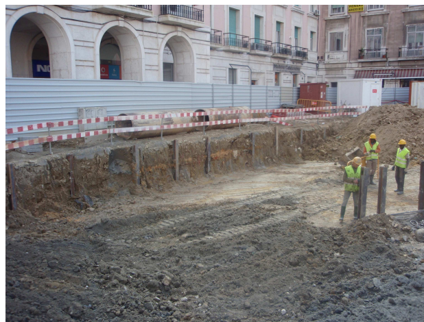
Figura 5 – colocação de perfis HEB durante a execução de muros berlinenses
