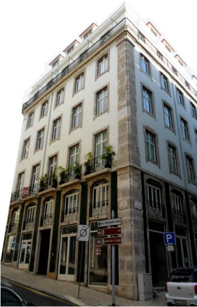
Fig. 9 - Fotografia de edifício Pombalino, na Rua da Madalena, Baixa Chiado Lisboa, registo do autor.
