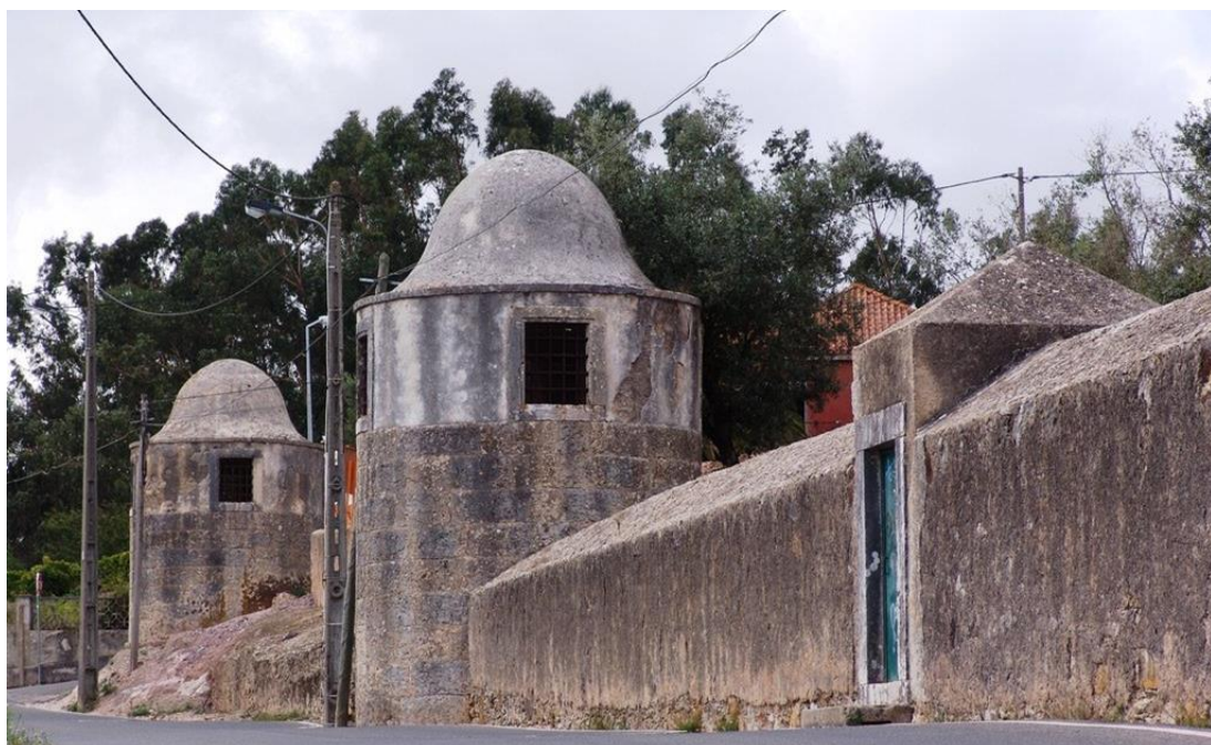
Figura 4 - Exterior do Aqueduto, em Caneças. Fonte: https://www.cm-odivelas.pt/pages/723?poi_id=25
