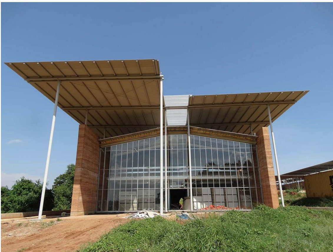
Figura 21 | Vista exterior do edifício, Fachada cortina com paredes exteriores em taipa e dupla cobertura.
