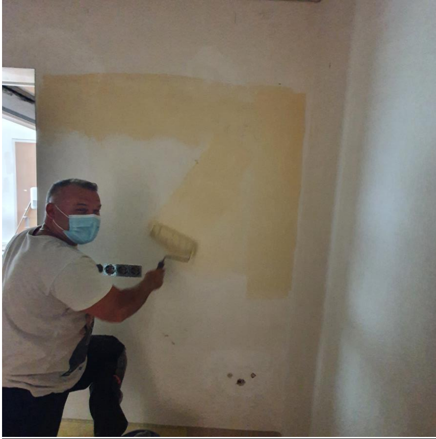
Figura 29 | Aplicação do vinílico nas paredes interiores
