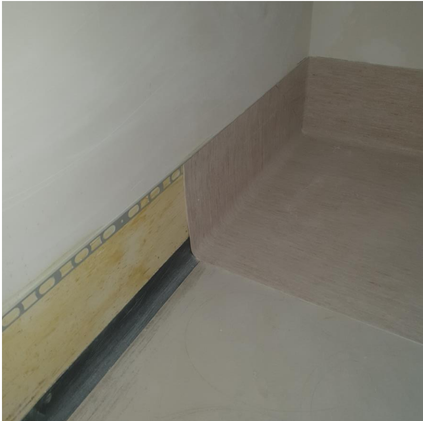
Figura 30 | Aplicação do vinílico nos pavimentos e ligação com as paredes interiores.
