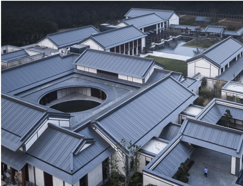
Figura 12 | Vista sobre a cobertura do edifício.
