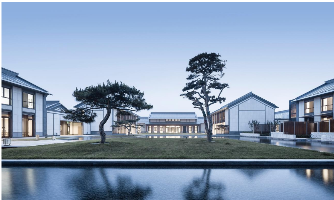
Figura 8 | Vista exterior do edifício integrado em pátios.
