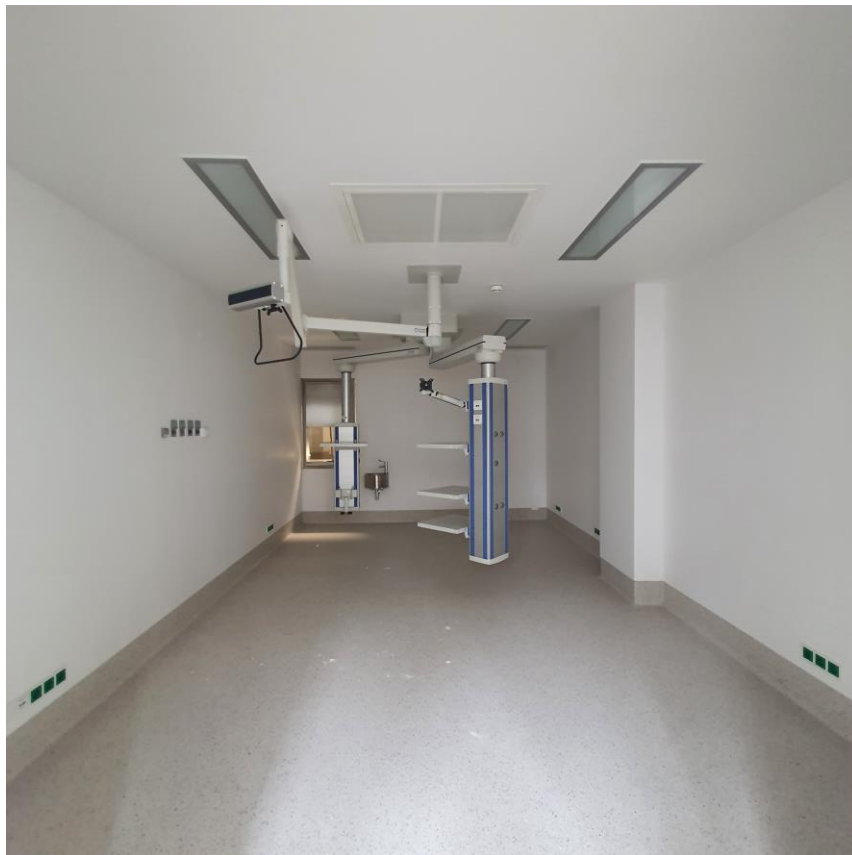
Figura 32 | Vista sobre bloco operatório
