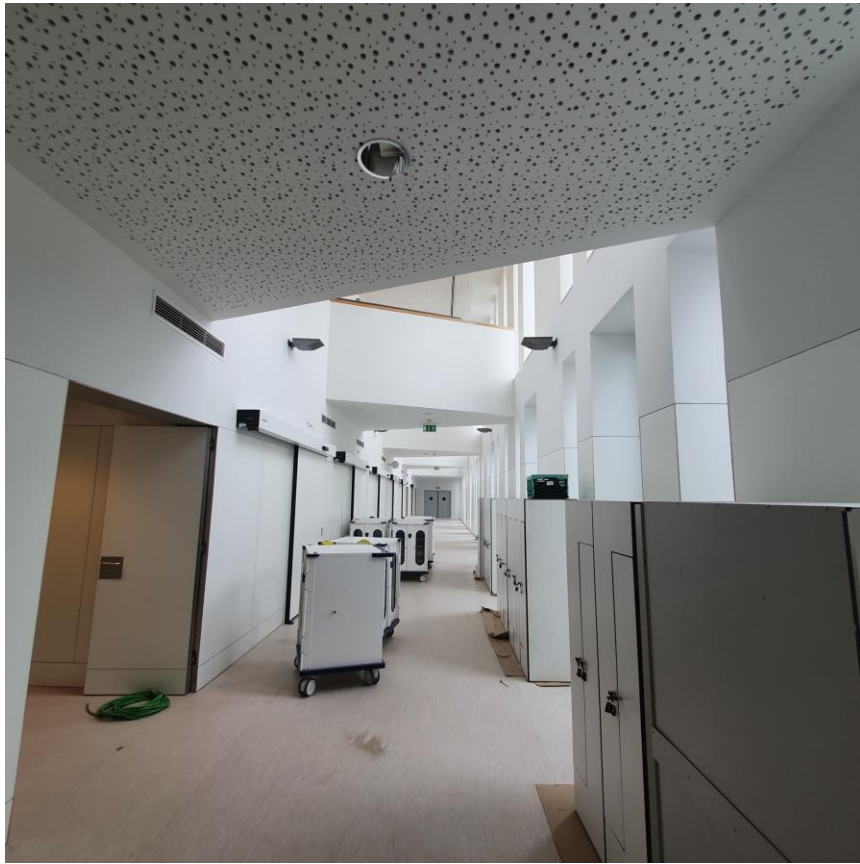
Figura 31 | Vista sobre circulação de acesso ao bloco operatório
