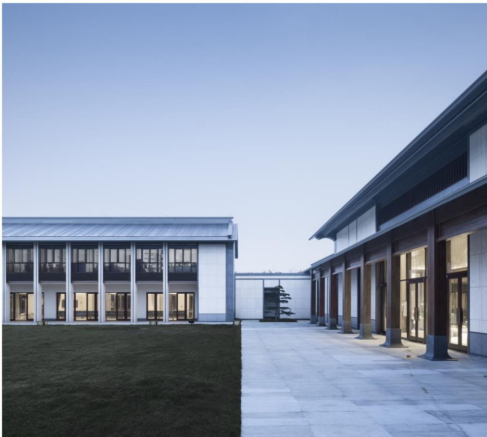
Figura 13 | Vista da circulação exterior integrada em pátios .
