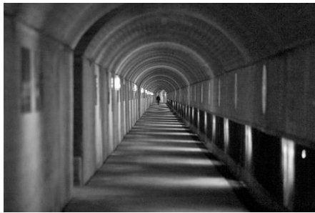
Figura 74 - Ambientes Molhes do Douro, Arquitecto Carlos Prata, 2005. Fonte: https://www.arcdaily.com.br/br/01-75903/molhes-do-douro-carlos-prata-arquitecto?ad_medium=gallery
