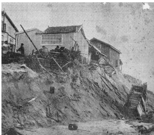
Figura 22 - Recorte do jornal O século, destruição das habitações provocada pelo avanço do mar Localização: Cova do Vapor
