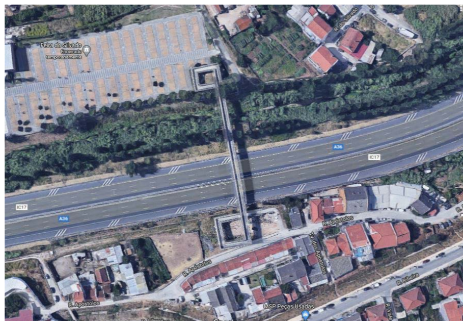
Fig. 56 - A passarela de Odivelas que atravessa o parque urbano e CRIL.
