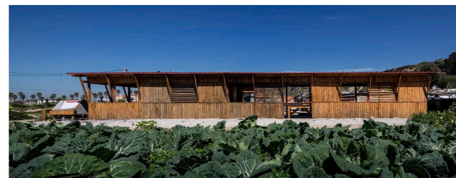
Fig. 39 - A diferença de uso do mesmo ripado de madeira na fachada.
