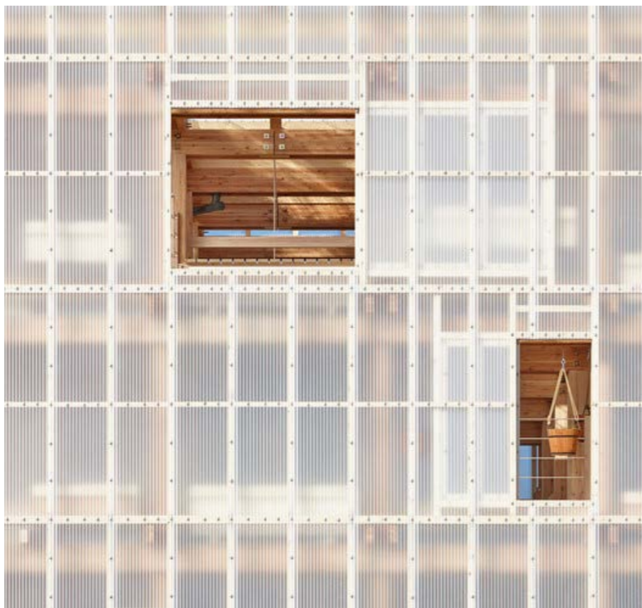
Fig. 30 - Materialidade da fachada com fechamento plástico em policarbonato.
