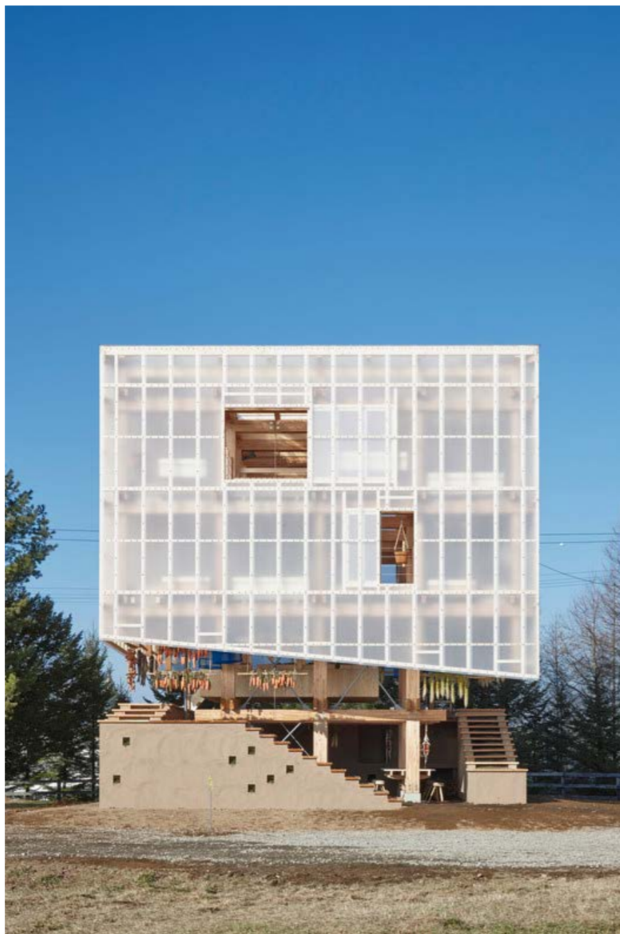
Fig. 28 - Fachada frontal do centro comunitário.
