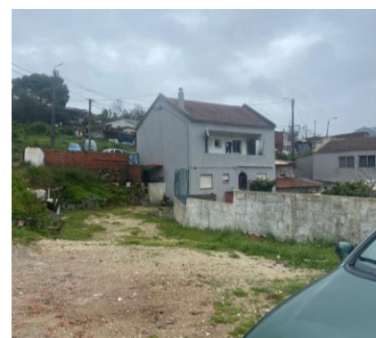
31. EXEMPLO DE RUA NÃO ALCATROADA fonte: autora
