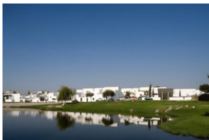
6. BAIRRO DA QUINTA DA MALAGUEIRA fonte: https://espacodearquitetura.com/projetos/bairro-da-malagueira/ Consultado a 10 de março de 2023
