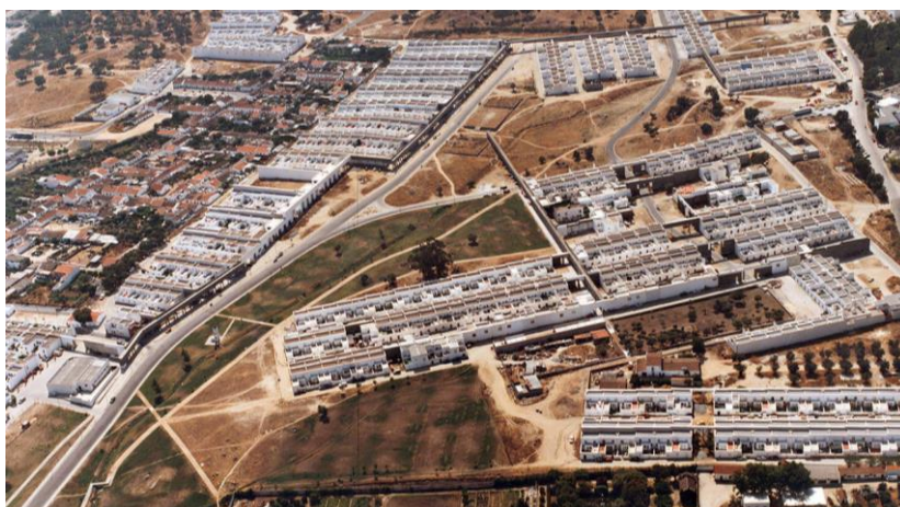
7. BAIRRO DA QUINTA DA MALAGUEIRA fonte: https://espacodearquitetura.com/projetos/bairro-da-malagueira/ Consultado a 10 de março de 2023
