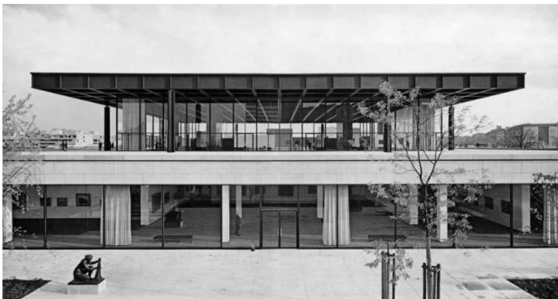
Fig. 34. Neue Nationalgalerie , Galeria Nacional de Berlim, Mies van der Rohe, 1968 [Retirada de: https://thedailyscan.com/2014/03/16/ludwig-mies-van-der-rohe_the-neue-nationalgalerie/ , data de acesso 15 de Maio de 2016].
