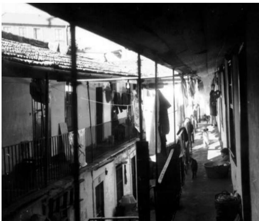
Figura 2 Imagem à direita, demonstra a rua interior das “ilhas” e a forma como estas se desenvolviam dentro dos longos e estreitos talhões de terreno no Porto. Fonte: https://pontosdevista.pt/2017/10/24/porto-ilhas-habitacionais-sao-problematica-diz-cdu/ , 2017
