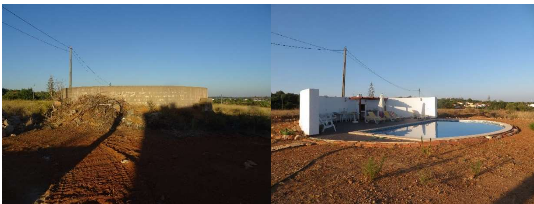
Figura 70 – Tanque de rega antes e depois da Intervenção
