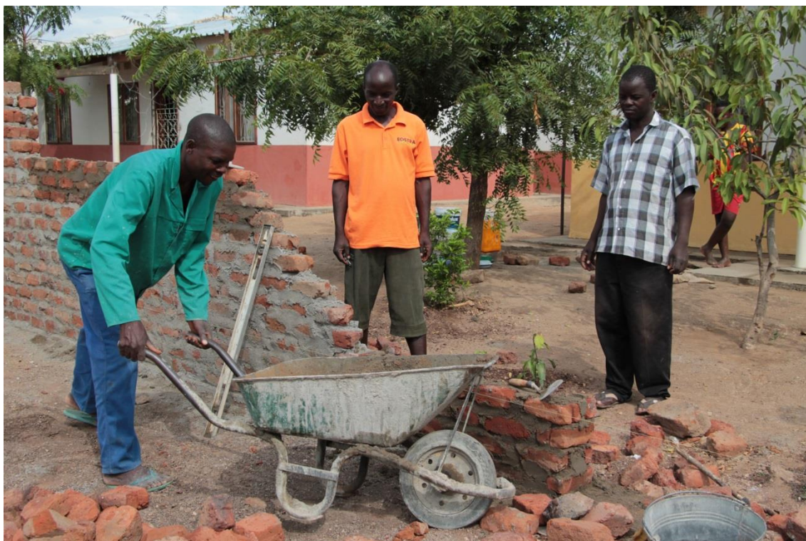
Ex combatentes da “guerra dos 16 anos” construir um muro no reassentamento do Bairro 25 de Setembro.
