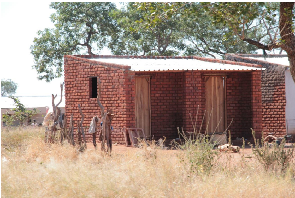
Anexos construídos pelos reassentados da Vale.
