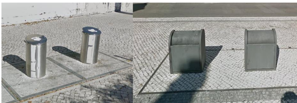
Figura 16 - Contentores de subterrâneos existentes no município de Santarém
