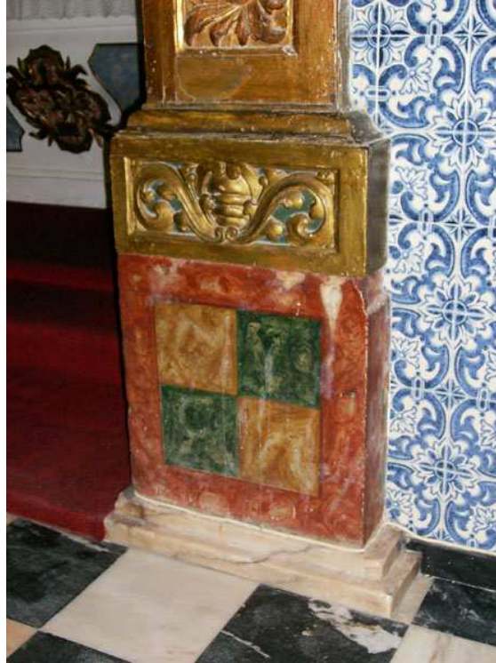
Fig. 192 – Base das colunas da capela-mor da igreja dos Jesuítas, Elvas.
