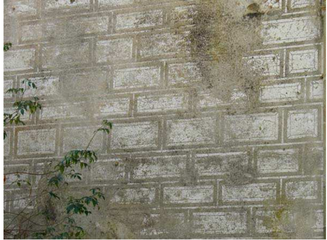
Fig. 33a – Revestimento de esgrafito (pormenor).
