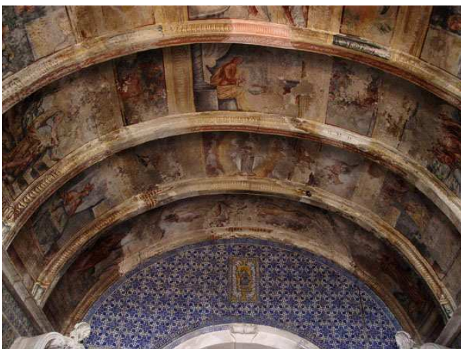
Fig. 164 – Interior da igreja de N.ª Sr.ª da Conceição, Monforte. Foto: Milene Gil.
