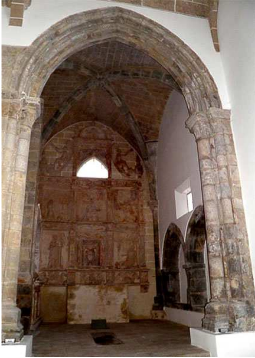
Fig. 211 – Capela de Gaspar Fragoso, igreja do convento de S. Francisco, Portalegre.
