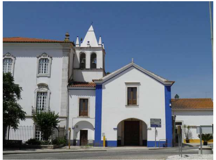
Fig. 129 – Fachada da igreja do convento de Santo António, Sousel.
