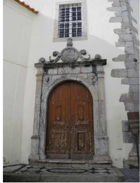
Fig. 330 - Fachada igreja de N.ª Sr.ª da Consolação, Elvas.
