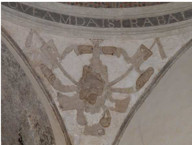
Fig. 292 – Mascarão e ferroneries (pormenor).
