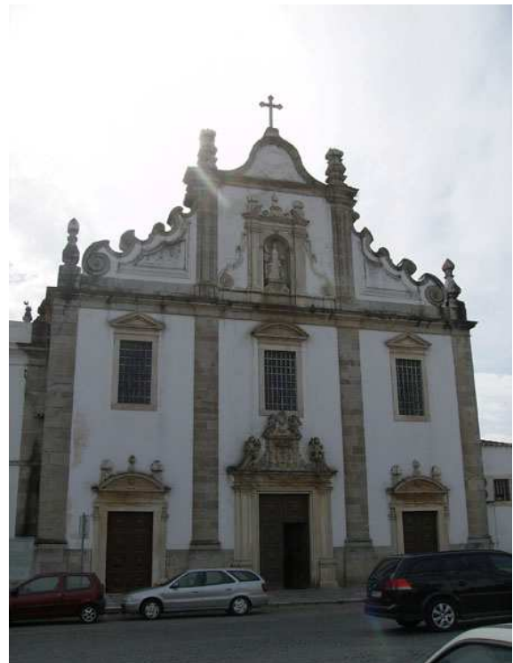
Fig. 328 – Fachada da igreja de S. Domingos, Elvas.
