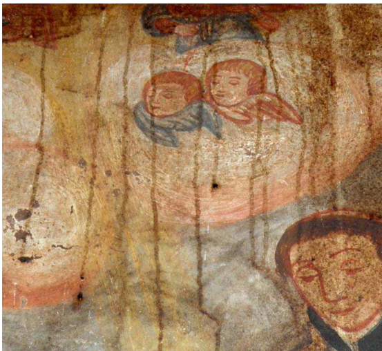
Fig. 303 – Escorrências sobre as pinturas do retábulo fingido (pormenor).
