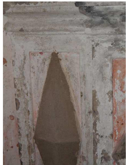
Fig. 364 – Introdução de rebocos de cimento no retábulo-mor (pormenor).
