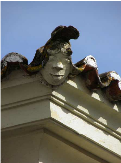
Fig. 217 – Imagem em massa no cunhal de um edifício na Praça da República, Portalegre.
