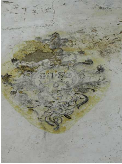
Fig. 155- Fachada no Largo Dr. José Regalla, Campo Maior, 1780.
