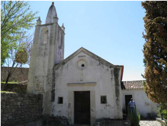
Fig. 343 – Igreja de N.ª Sr.ª do Pilar, Belver, Gavião.
