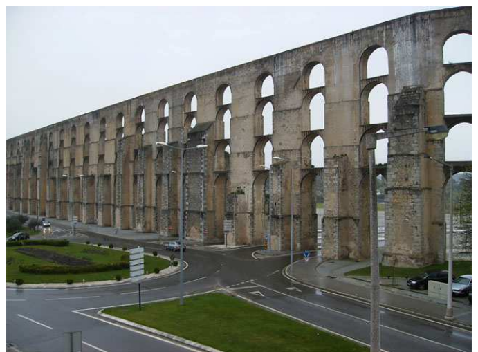
Fig. 54 – Aqueduto da Amoreira, Elvas.
