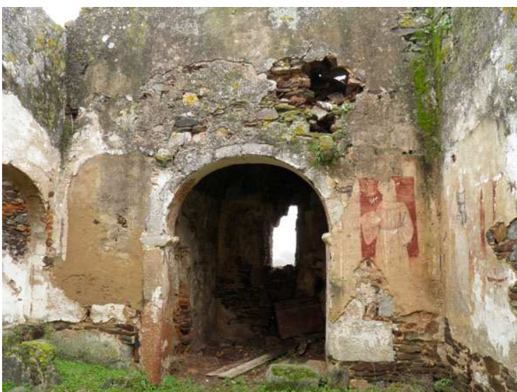
Fig. 352 – Interior da ermida com vestígios de pinturas nos alçados.
