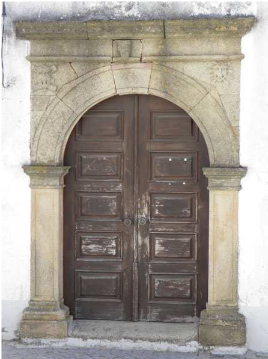
Fig. 353 – Fachada da igreja da Misericórdia de Arez.
