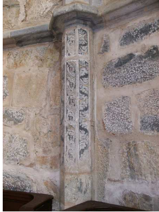
Fig. 196 – Fingimento de embutidos de mármore, igreja do convento de S. Domingos (pormenor), Elvas.
