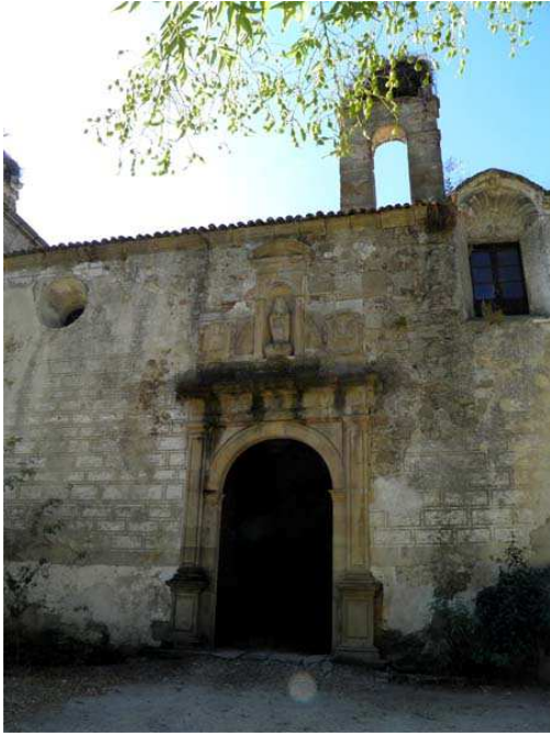
Fig. 33 – Fachada da mesma igreja com revestimento a esgrafito.
