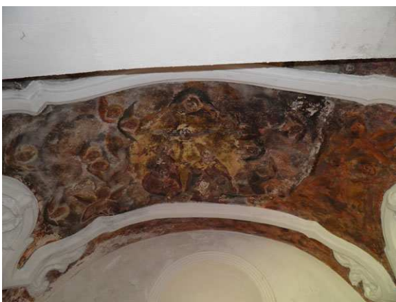
Fig. 375 – Abóbada da capela, convento de Santa Clara, Portalegre.
