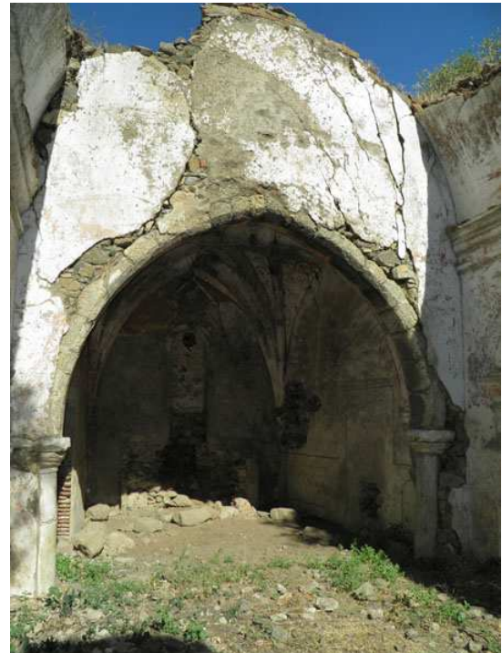
Fig. 360 – Interior da ermida de N.ª Sr.ª dos Santos, Tálga, Olivença.
