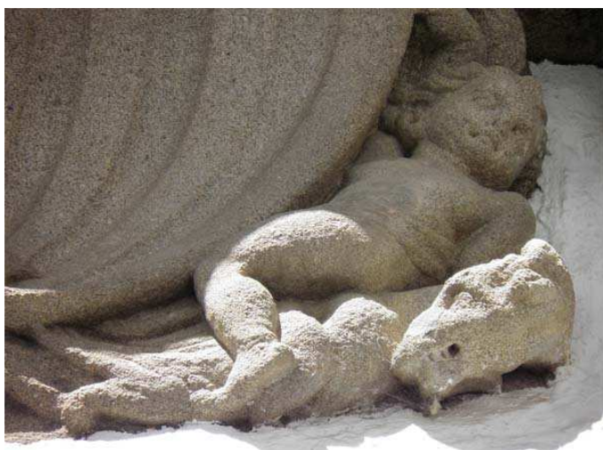
Fig. 10 – Decorações no edifício da R. Luís de Camões, Portalegre (pormenor).
