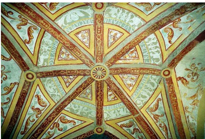
Fig. 150 – Capela-mor da igreja de N.ª Sr.ª da Redonda, Alpalhão.
