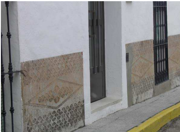
Fig. 34 – Edifício com decoração de esgrafitos na localidade de San Jorge, Olivença.
