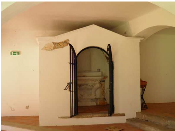
Fig. 374 – Capela, convento de Santa Clara, Portalegre.
