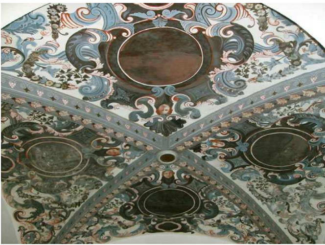
Fig. 139 - Claustro do convento de S. Francisco de Elvas, finais do séc. XVII.
