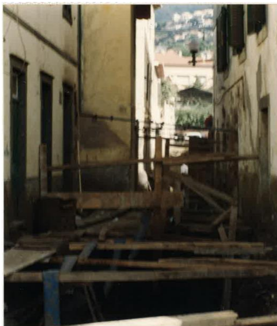
Figura 20 - Intervenção de saneamento básico e calcetamento numa das artérias da Zona Velha
