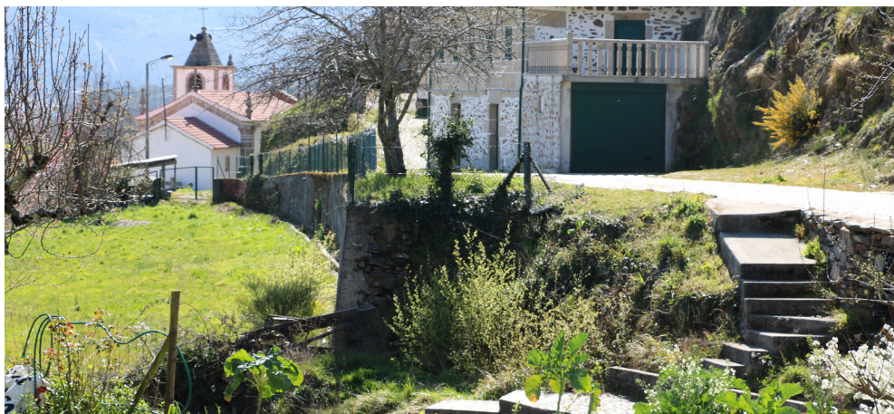
FIGURA 147 | O ACESSO AO POÇO
