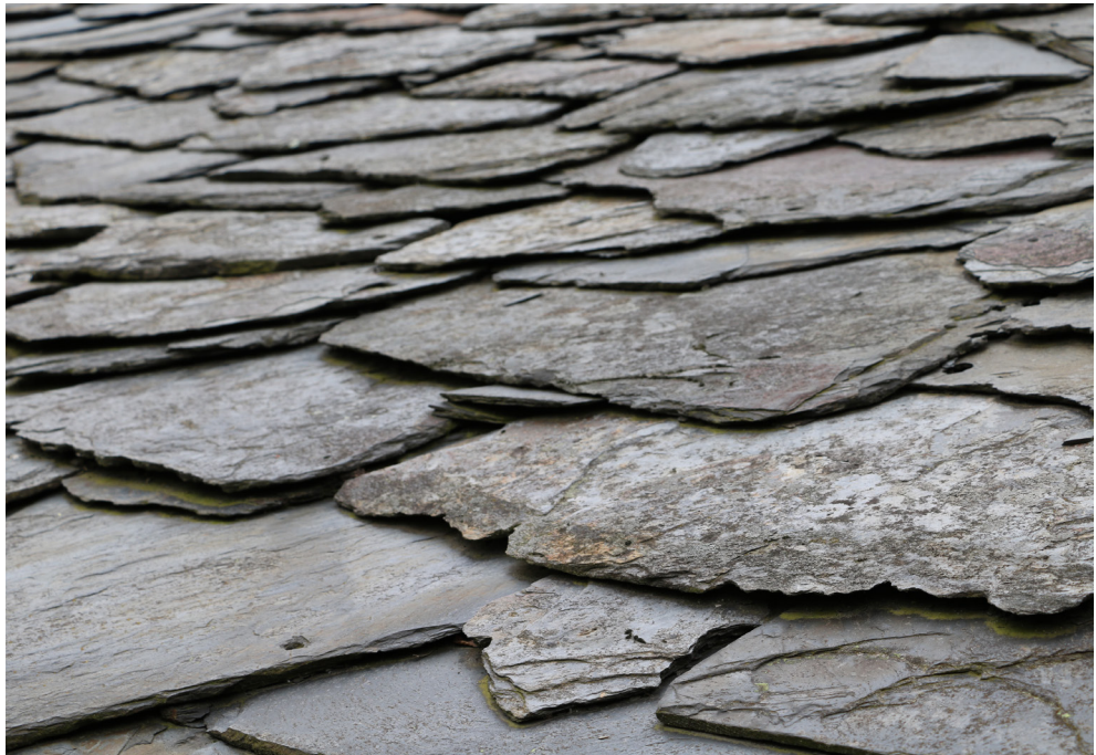
FIGURA 83 | O TELHADO TÍPICO
