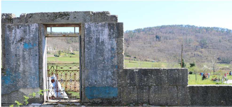
FIGURA 138 | O ALÇADO FRONTAL VISTO DO INTERIOR
