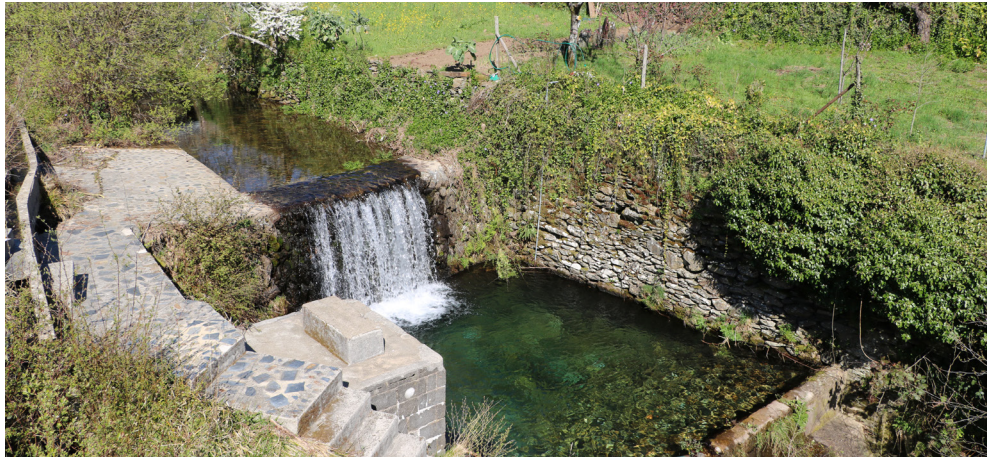
FIGURA 146 | O POÇO DA BOMBA
