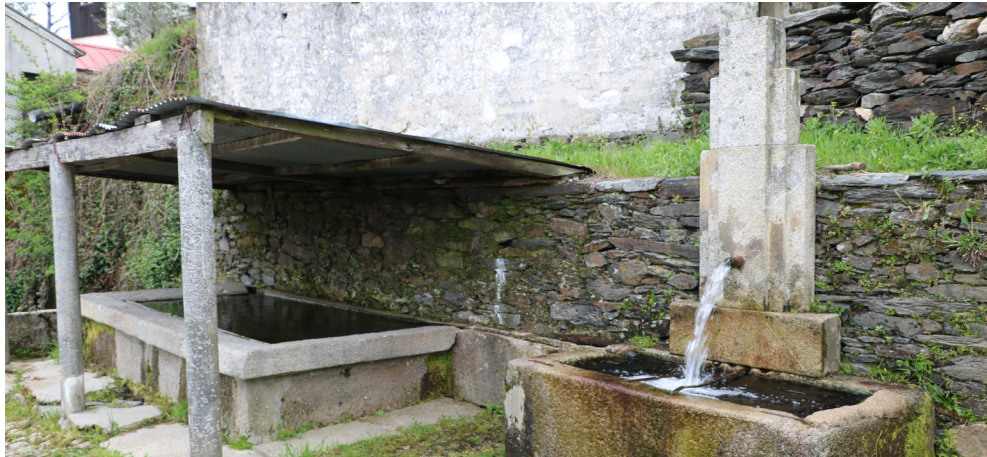
FIGURA 15 | O CICLO DA ÁGUA - Em primeiro plano o fontanário ao qual se segue o tanque de roupa.
