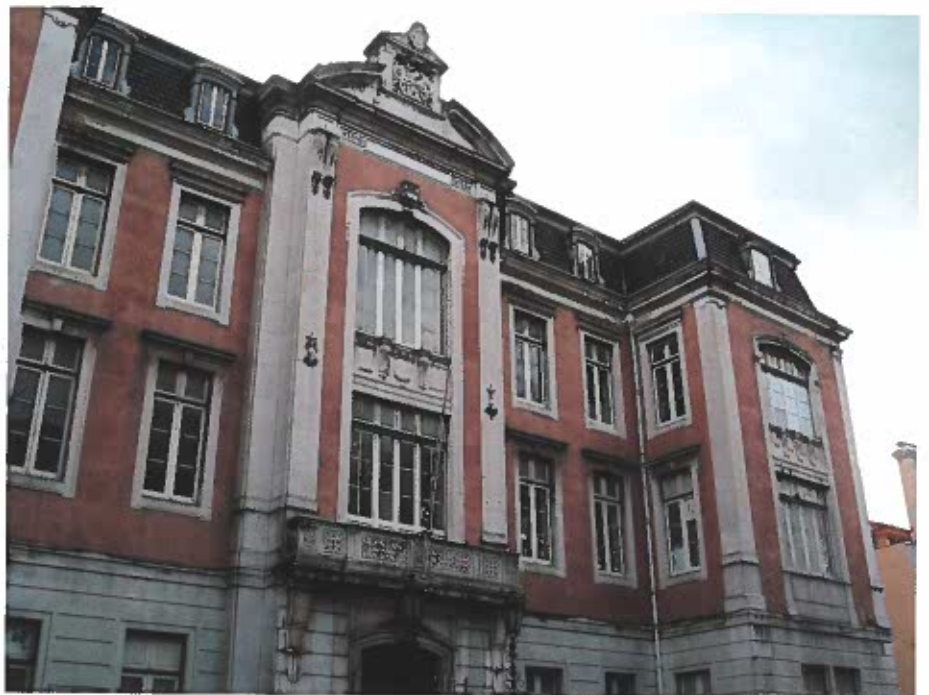
[Foto 5] – Antiga Escola Industrial Marquês de Pombal (hoje Escola Secundária Fonseca Benevides). Fachada principal. Fotografia actual da autoria do Arquitecto João Paulo Martins.
