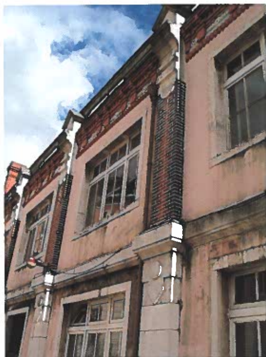
[Foto 7] – Antiga Escola Industrial Marquês de Pombal (hoje Escola Secundária Fonseca Benevides). Fachada das Oficinas Anexas que dista para a Rua de Alcântara. Observe-se o carácter fabril adoptado pelo Arquitecto, em conformidade com as funções oficiais deste anexo. Fotografia actual da autoria do Arquitecto João Paulo Martins.
