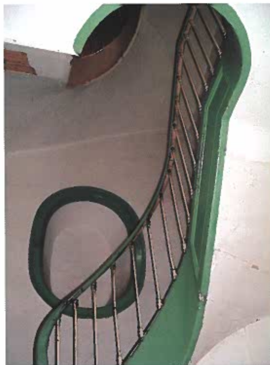
[Foto 8] – Antiga Escola Industrial Marquês de Pombal (hoje Escola Secundária Fonseca Benevides). Pormenor do interior do edificio das Oficinas. Fotografia actual da autoria do Arquitecto João Paulo Martins.
