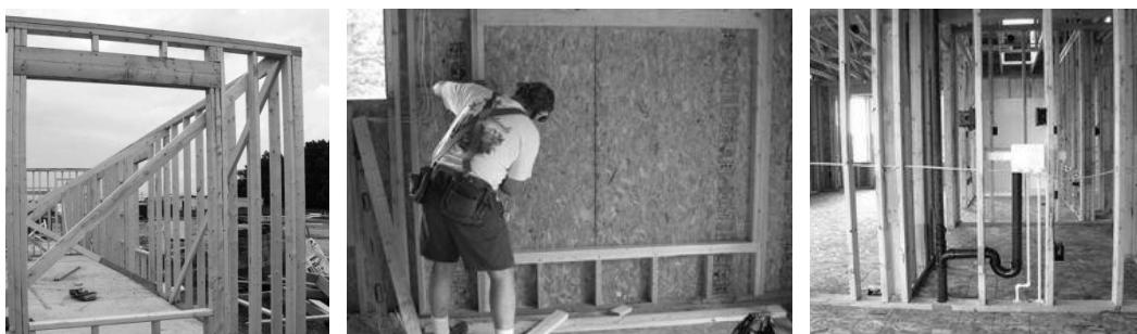
Imagens 45, 46 e 47 Construção de uma parede com vão, do forro estrutural e da instalação da canalização
