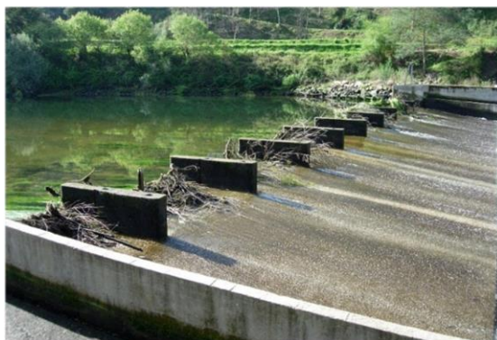
Figura 19. Açude do Louredo antes das intervenções.
