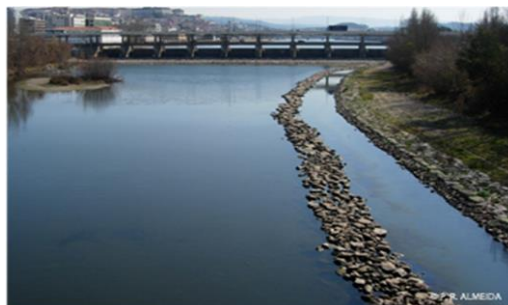
Figura 10. Canal a jusante do Açude-Ponte de Coimbra, rio Mondego.
