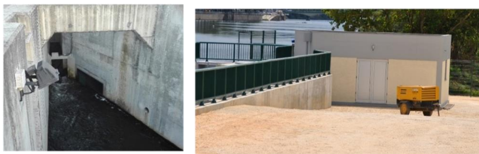
Figura 11. Respetivo estreitamento do canal da PPPeixes do Açude-Ponte (esquerda) e estação de monitorização (direita).
