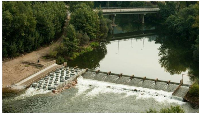
Figura 20. Açude do Louredo e as respetivas infraestruturas (PPPeixes e rampa de caiaques).
