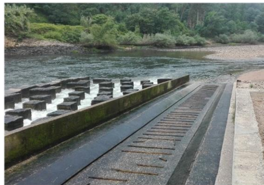
Figura 23. Destaque da rampa para caiaques na margem direita do açude do Louredo.
