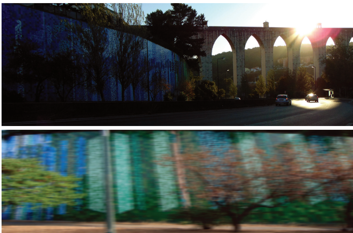
Fig. 7 | João Abel Manta, Lisboa, Avenida Calouste Gulbenkian, muro de suporte de terras, 1970-1982 [cima]
