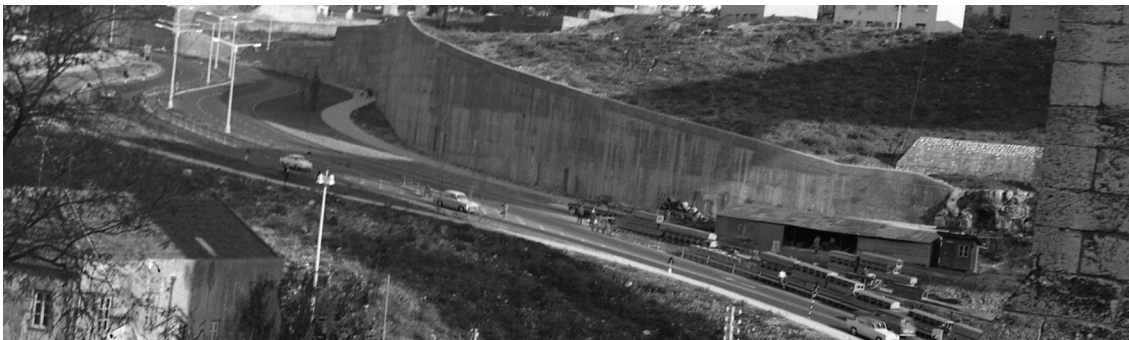
Fig. 9 | Lisboa, Avenida Calouste Gulbenkian, muro de suporte de terras, cód. ref. (PT/AMLSB/JHG/S02092) [antes da aplicação do revestimento cerâmico de João Abel Manta] [© AMLAF | Fotógrafo: João H. Goulart, 1968]
