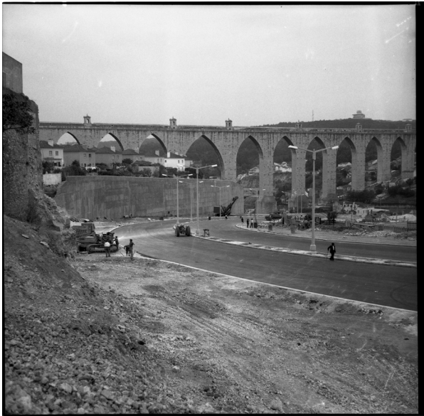
Fig. 76 | Lisboa, Avenida Calouste Gulbenkian, muro de suporte de terras, cód. ref. PT/AMLSB/JBG/S00330 [antes da aplicação do revestimento cerâmico de João Abel Manta] [© AMLAF] Fotógrafo: João H. Goulart, 1968]
