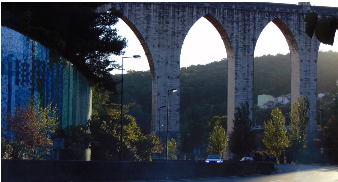
Fig. 80 | João Abel Manta, Lisboa, Avenida Calouste Gulbenkian, muro de suporte de terras, 1970-1982
