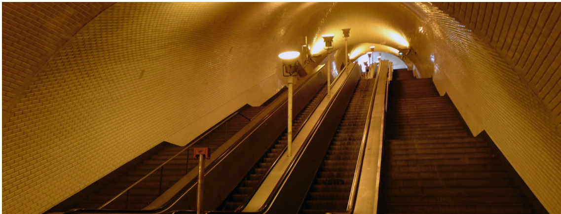
Fig. 132 | Álvaro Siza Vieira, Lisboa, Metropolitano de Lisboa, Estação Baixa-Chiado, escadas de acesso [exterior-átrio], 1992-1998
