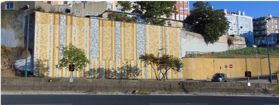
Fig. 77 | João Abel Manta, Lisboa, Avenida Calouste Gulbenkian, muro de suporte de terras, 1970-1982
