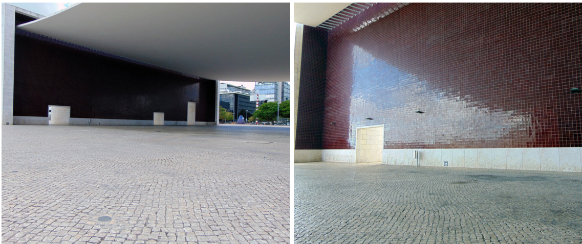
Fig. 97 e 98 | Álvaro Siza Vieira, Parque das Nações, Pavilhão de Portugal, 1995-1998
