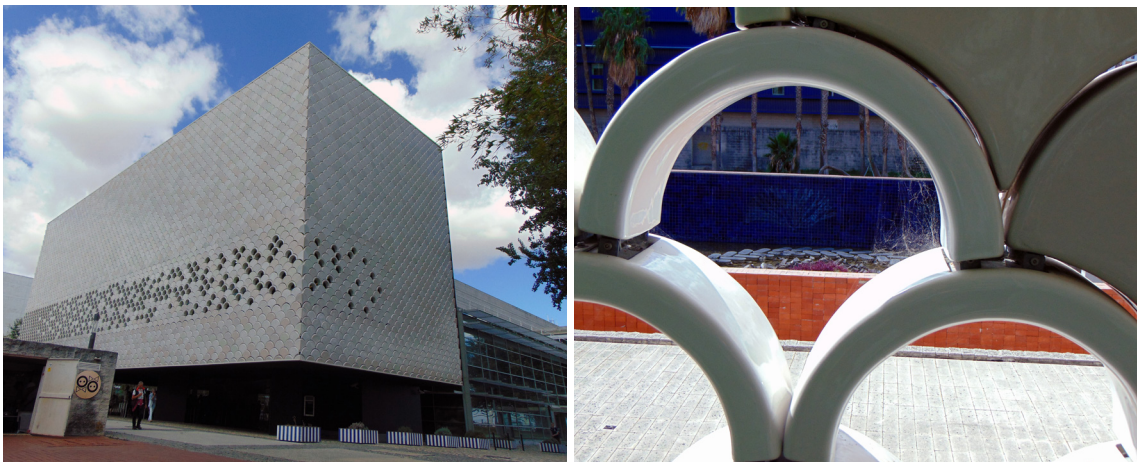
Fig. 104 | Toni Cumella Vendrell, Parque das Nações, Edifício do Mar, fachada, 2011 [esquerda]
