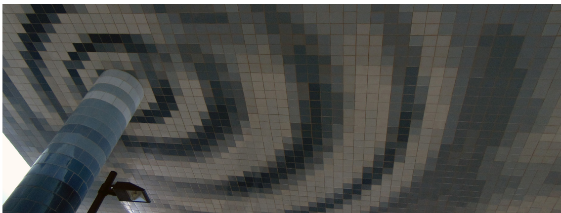
Fig. 151 | Catarina Almada Negreiros e Rita Almada Negreiros, Cota Zero , Terreiro do Paço, Estação Fluvial Sul e Sueste, novo átrio, 2001 [pormenor do revestimento cerâmico]
