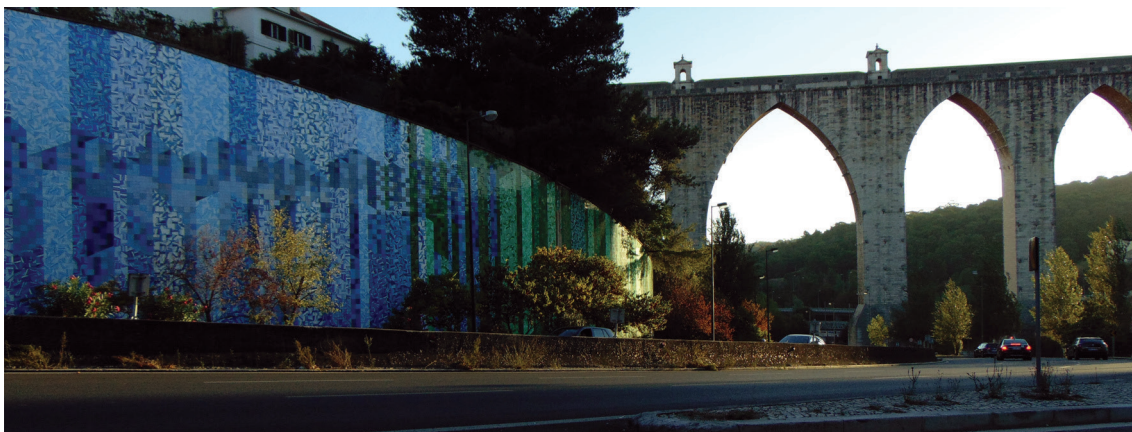
Fig. 5 | João Abel Manta, Lisboa, Avenida Calouste Gulbenkian, muro de suporte de terras, 1970-1982
