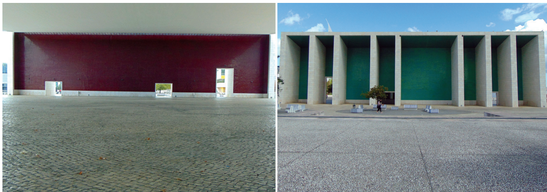
Fig. 20 e 21 | Álvaro Siza Vieira, Parque das Nações, Pavilhão de Portugal, 1995-1998
