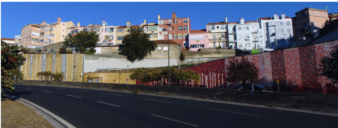
Fig. 78 | João Abel Manta, Lisboa, Avenida Calouste Gulbenkian, muro de suporte de terras, 1970-1982
