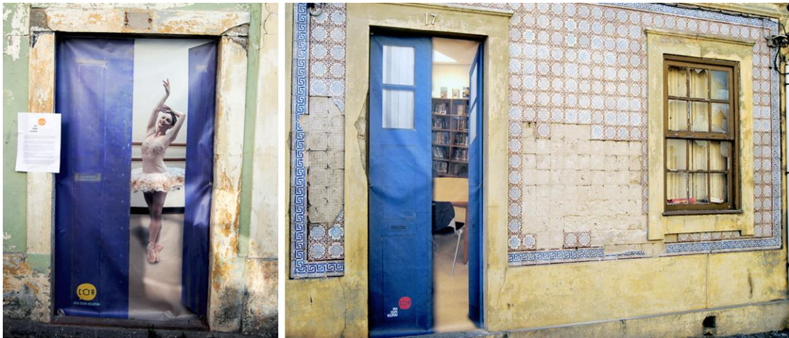
Figs. 83 e 84: Fachadas de edifícios com aplicações COR
