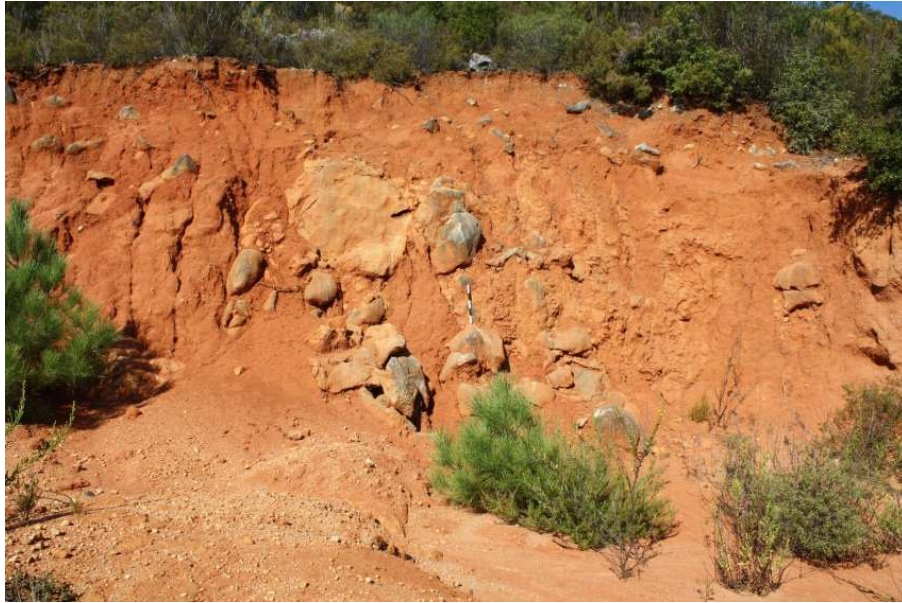
Foto 18 – Vista geral da unidade M 5 SA registando-se a presença de calcários de cor amarelada, cobertos por depósitos detríticos de cor alaranjada.
