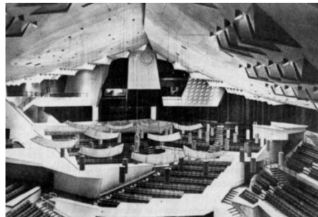
Fig. 6.55- Filarmónica de Berlim, perspectiva com destaque para os ressoadores de Helmholtz (Carrión Isbert, 1998)
