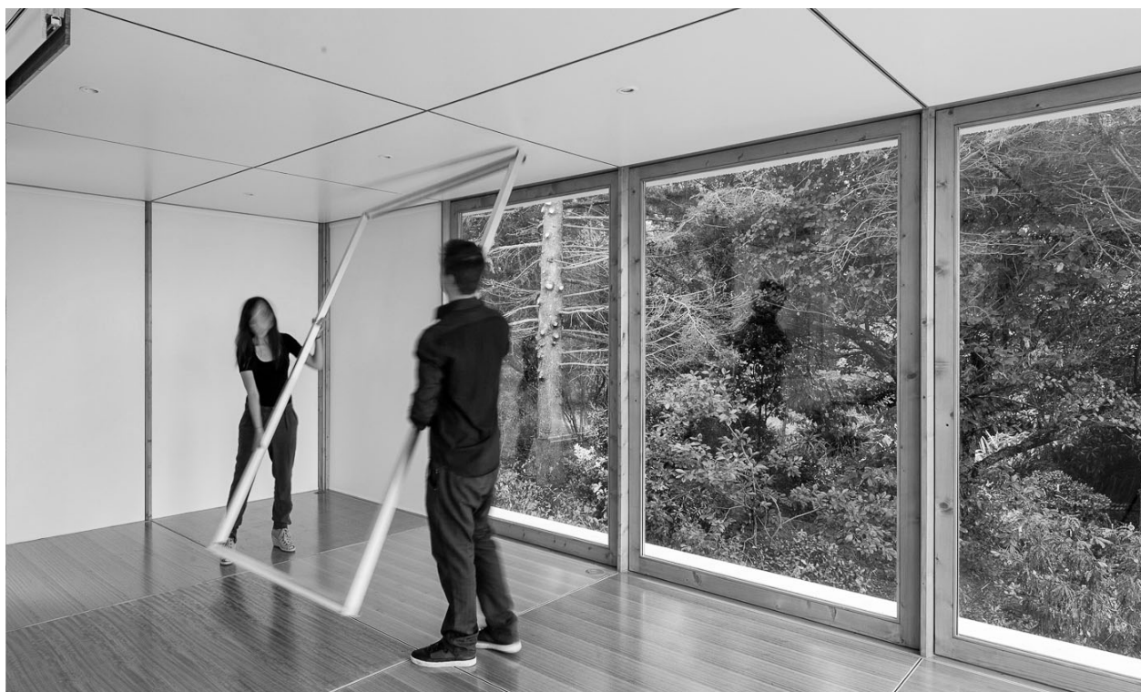
Fig.43_ Fotografia da colocação dos painéis internos divisórios do projecto MIMA HOUSE.
