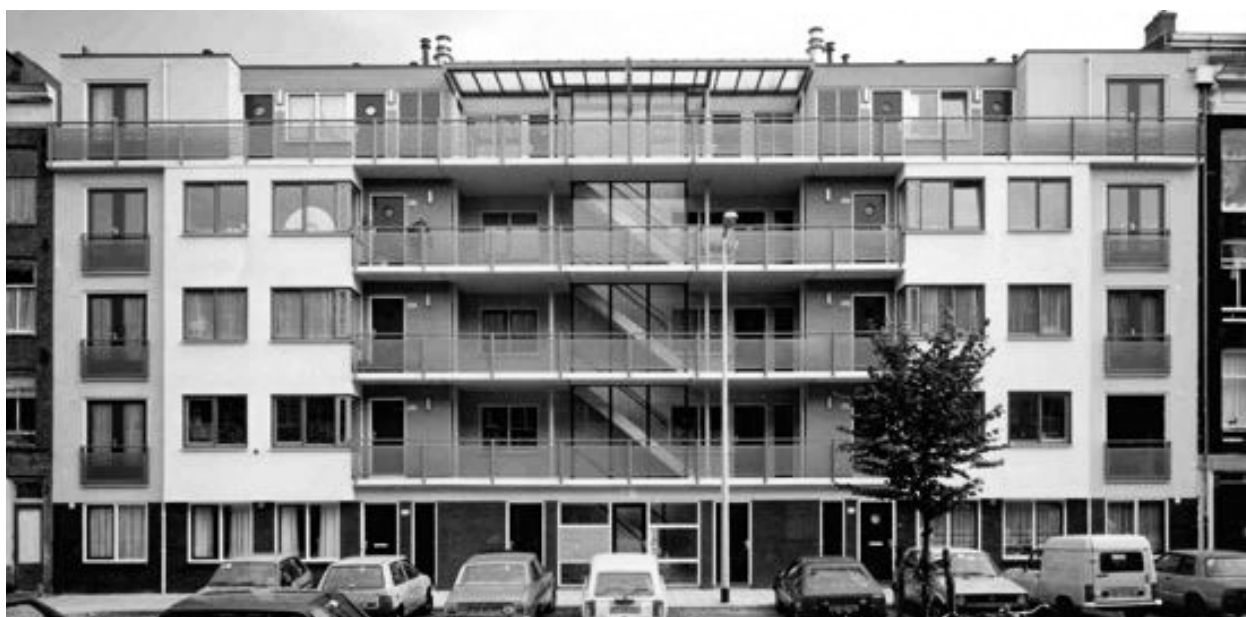
Fig.23_ Fotografia exterior do edifício Duinker Van der Torre.
