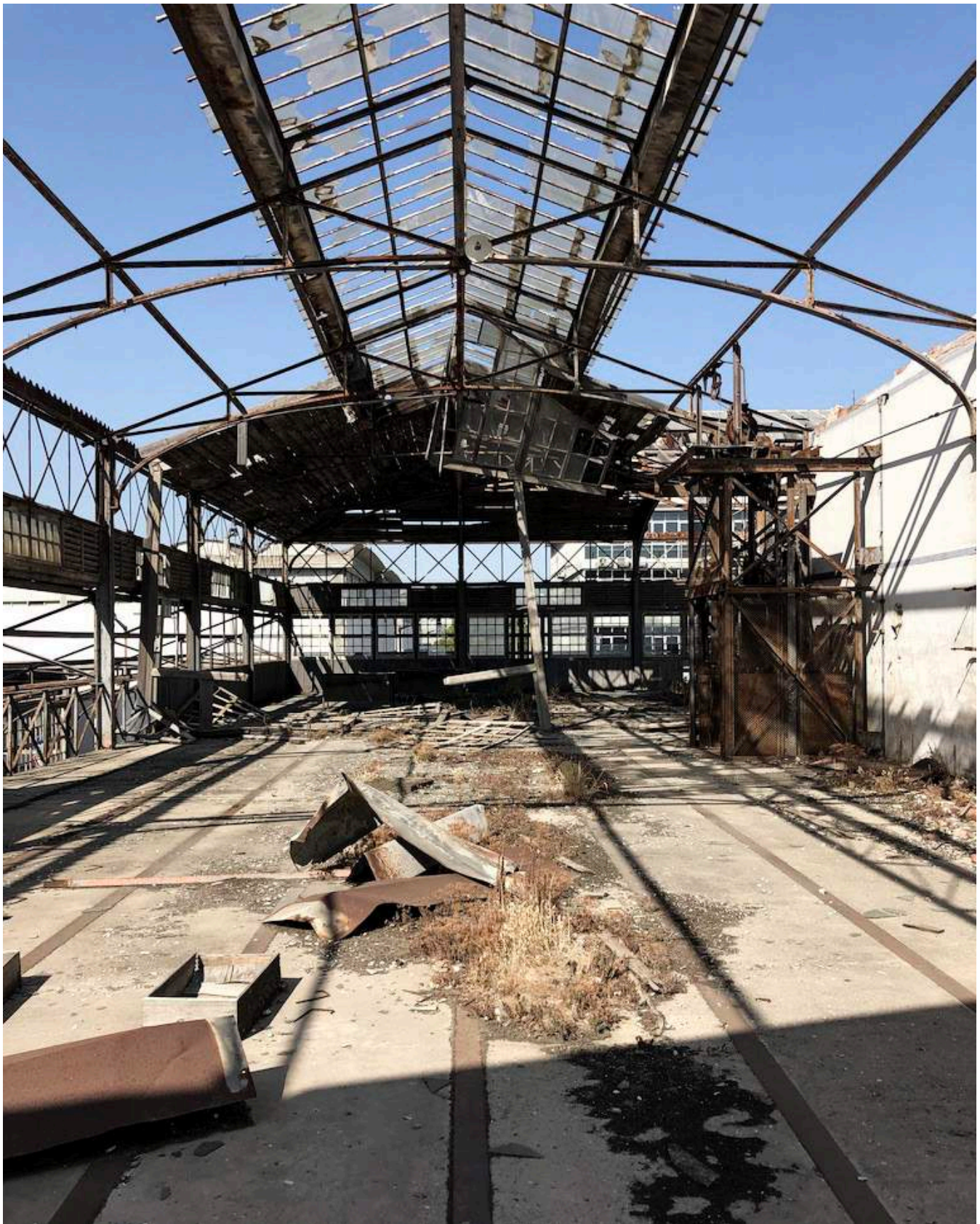
FIG33 _ FOTOGRAFIA NO INTERIOR DA TABAQUEIRA, COM AS CARACTERÍSTICAS ASNAS METÁLICAS.
