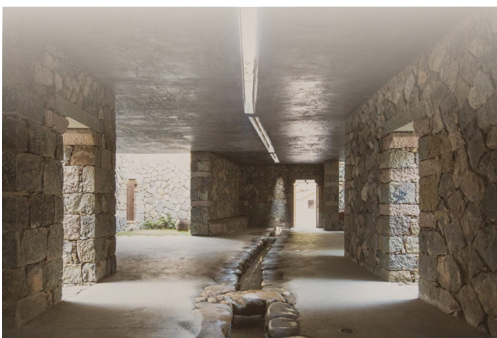
036. Vista do interior com o vão da cobertura.
