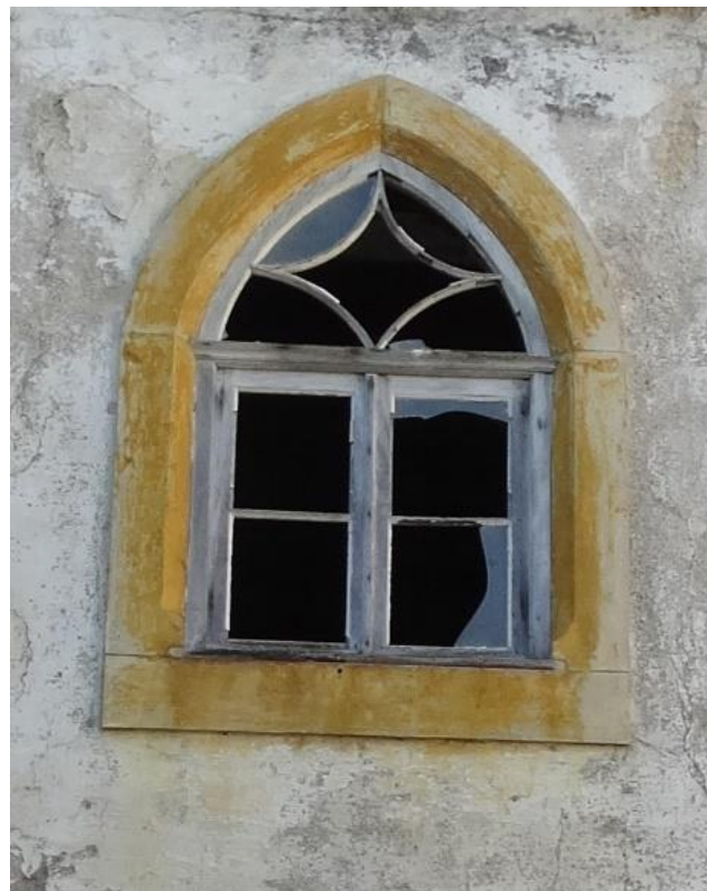
Figura 43 Vão exterior, Alçado Sul, Paço
