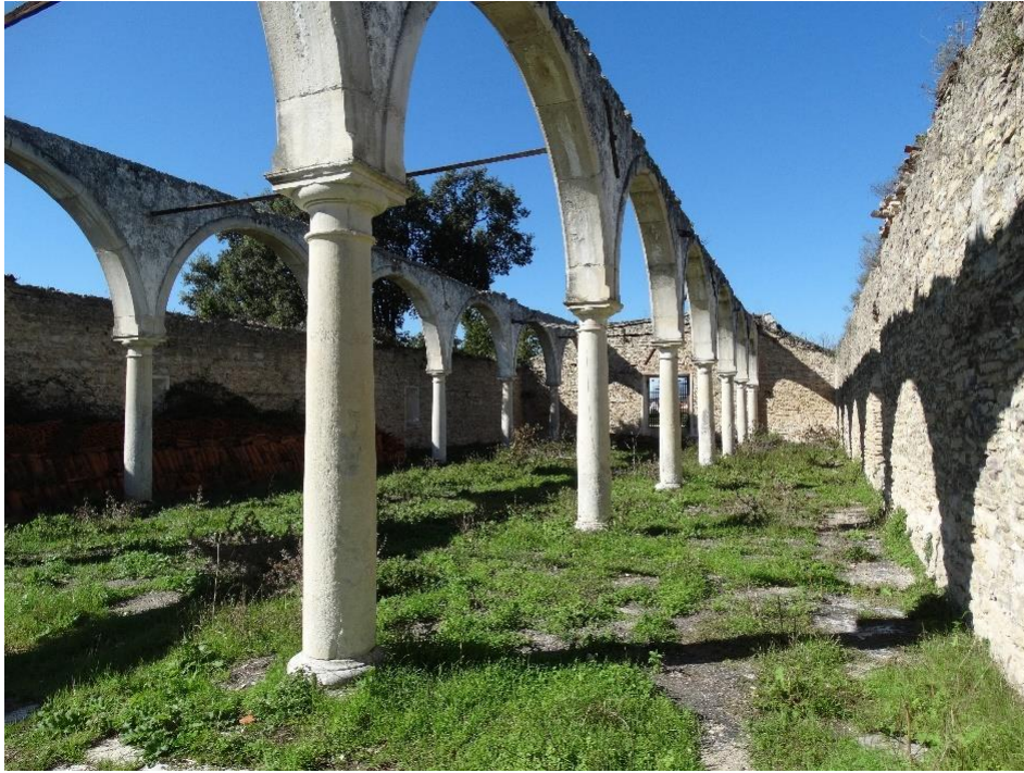
Figura 10 Nave interior do Celeiro Grande, existente
