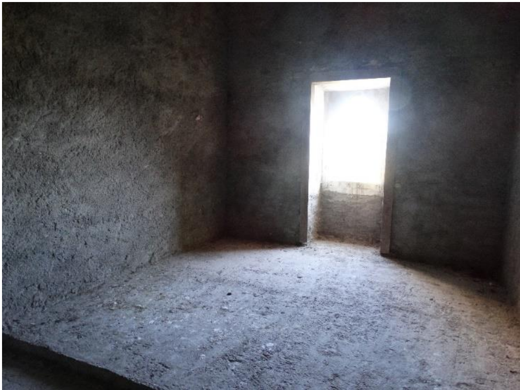
Figura 40 Interior do Edifício do Paço (Nível 1)
