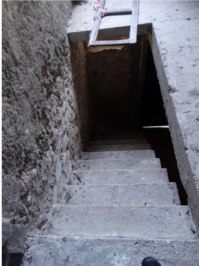
Figura 39 Interior do Edifício do Paço (Nível 1)
