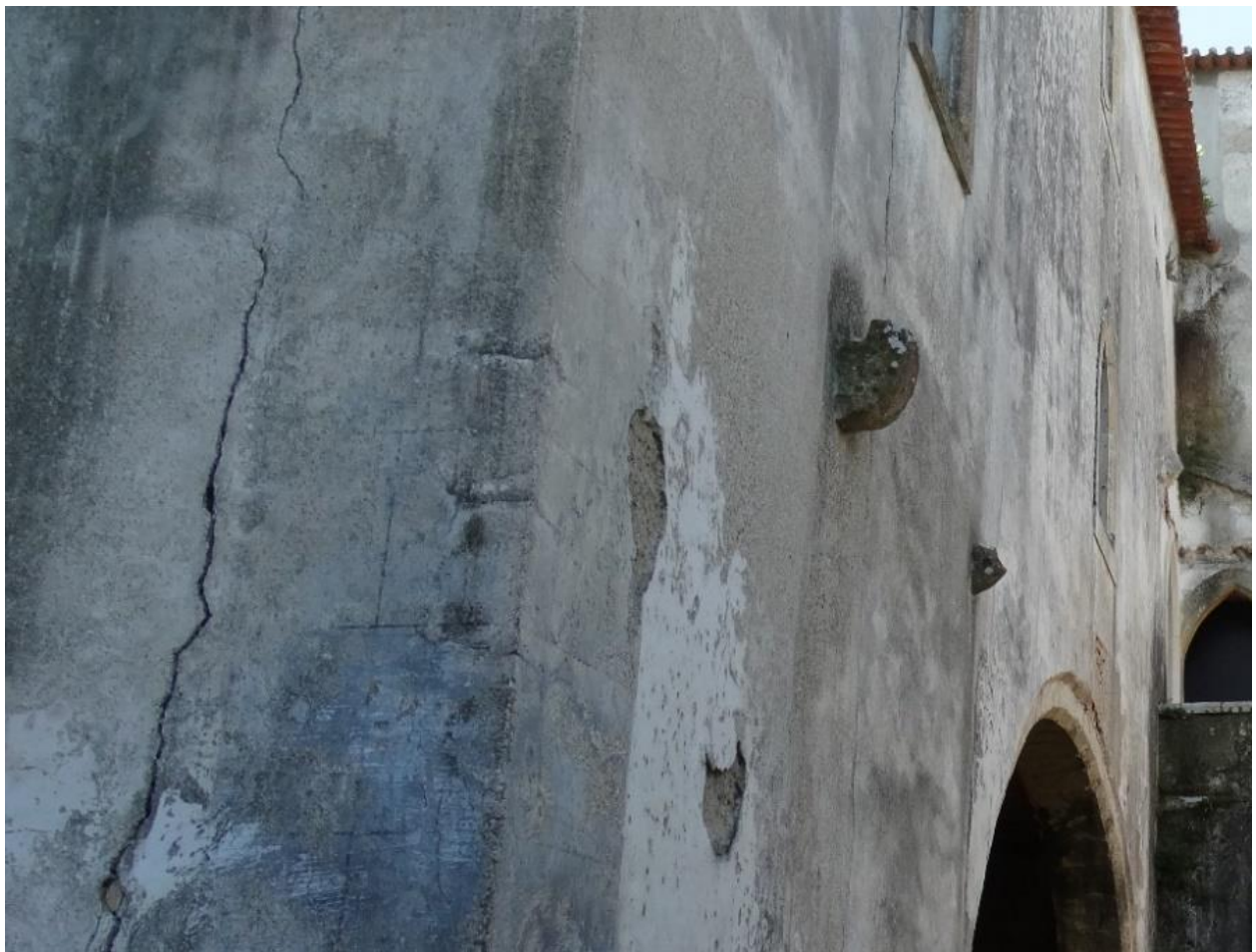
Figura 41 Fissuração, Alçado Nascente do Paço
