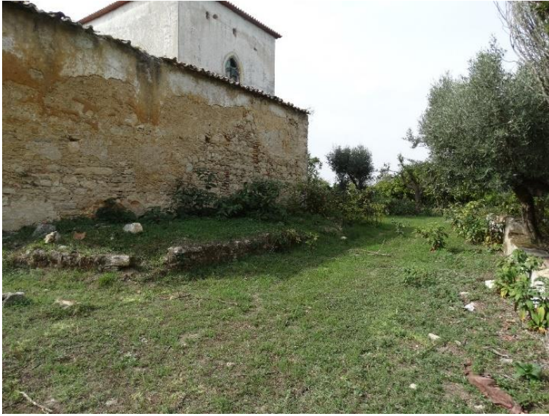
Figura 104 Alçado Nascente do Paço
