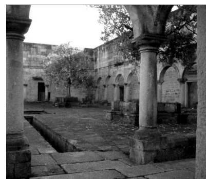
72 e 73: O claustro como ruína viva. Fonte: Ana Monteiro.
