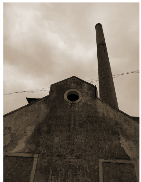
3: A Fábrica da Samaritana. Vista da casa das máquinas. 2018, fotografia do autor.
