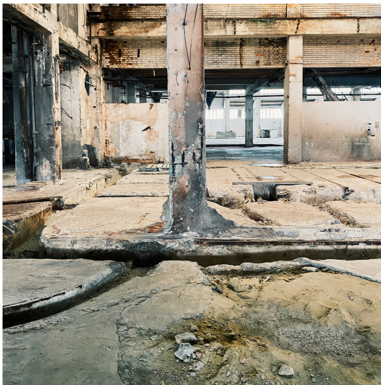
83. Vestígios de um passado industrial. Cimianto. Fotografia da autora 2020.
