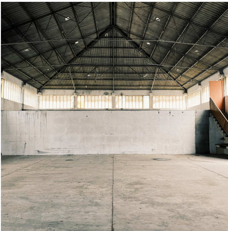
54. Nave industrial. Cimianto. Fotografia da autora 2020.
