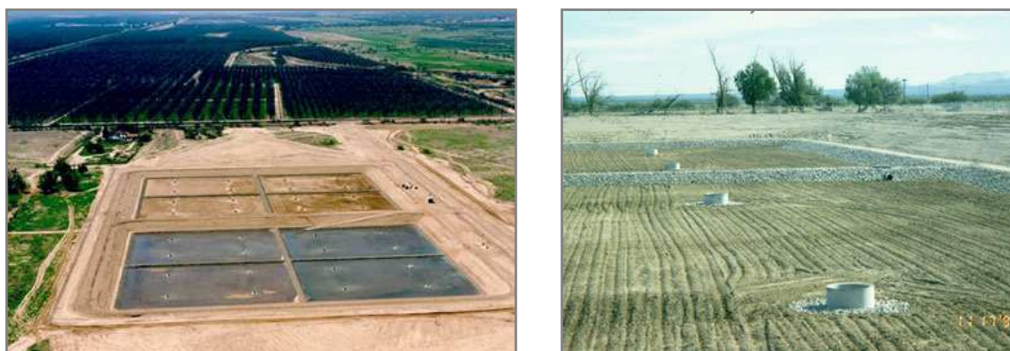
Figura A.4 – Bacias de infiltração do Projecto de Pima Mine Road (lado esquerdo em operações de manutenção secagem e recarga e lado direito após a raspagem do fundo) (CAP, 2007).
