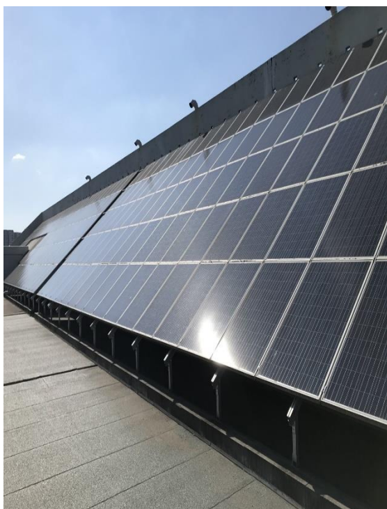
Figura 62 – Registo fotográfico dos telhados da FCUL
