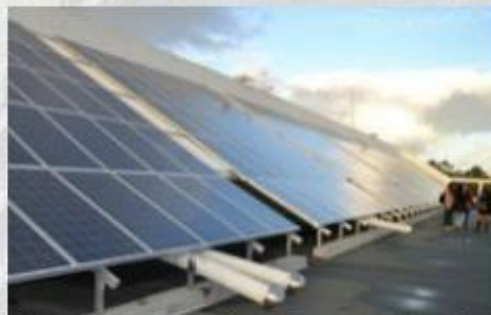
Telhados da FCUL
