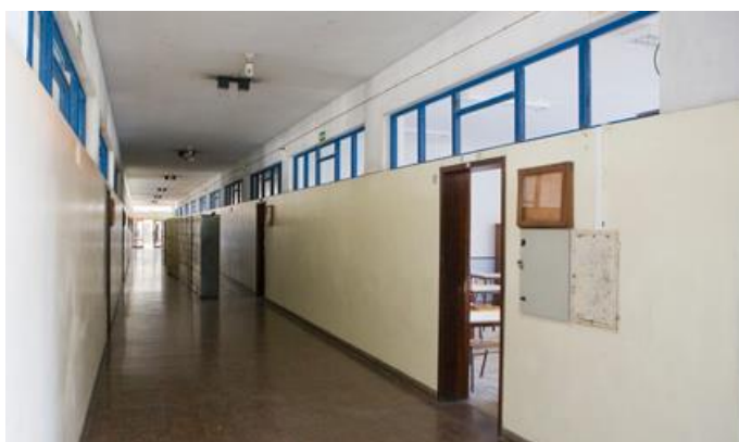
Figura 5 – Escola Secundária Rainha Dona Leonor antes da intervenção ocorrida em 2009 (1)
