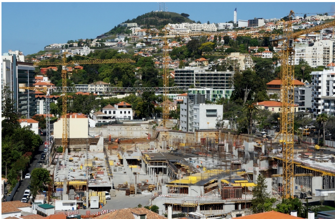
Figura 121: Massiva infraestruturação e impermeabilização do terreno, comprometendo qualquer relação direta com o solo natural. ( Skyscrapercity https://www.skyscrapercity.com/threads/madeira-hotel-savoy-palace.300002/page-12?nested_view=1&sortby=oldest#replies )
