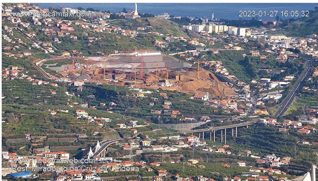
Figura 169: O escasso solo com potencial produtivo ocupado de maneira inconsequente. Preparação do terreno para o novo hospital, com a construção de grandes muros de suporte – paisagisticamente desproporcionais. Para a execução da obra houve necessidade de realizar muitas expropriações, implicando gastos financeiros públicos. (Madeira Web. https://www.madeira-web.com/pt/noticias/novo-hospital-da-madeira.html )
