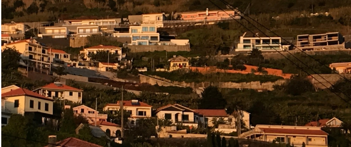
Figura 152: Zona no Arco da Calheta (março, 2025). Diferença entre as construções mais recentes, na parte superior, e as antigas, logo abaixo. Destaca-se o impacto visual negativo dos grandes vãos envidraçados e dos seus reflexos, que acentuam a desproporção dos edifícios. Ao contrário das dimensões clássicas das aberturas (cerca de um metro acima do piso), estas janelas sobredimensionadas comprometem uma leitura equilibrada e humanizada da escala arquitetónica.
