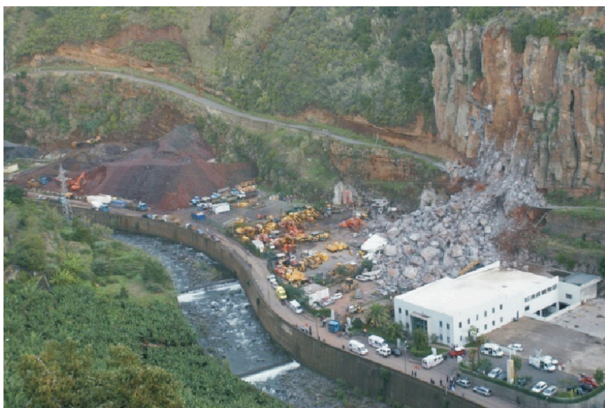
Figura 14: Movimento de massa simples no vale da Ribeira dos Socorridos. (Abreu et al. , 2009)
