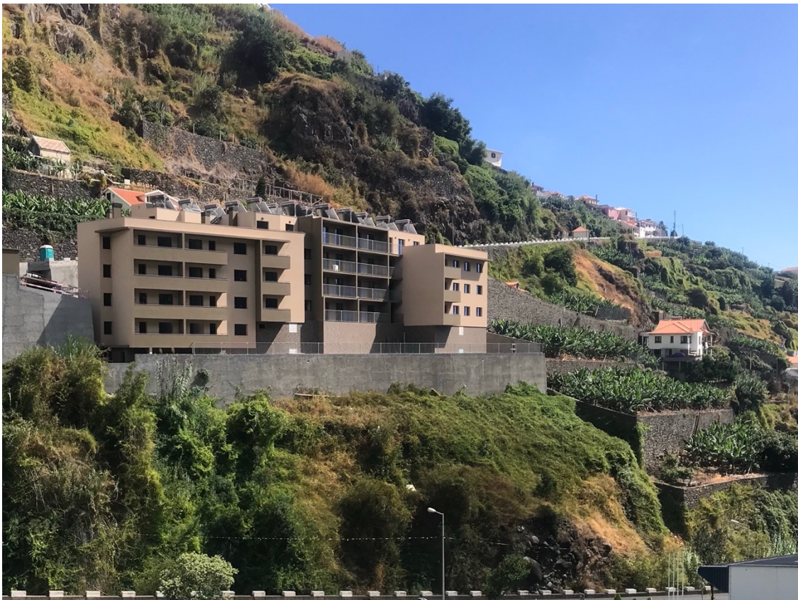
Figura 140: Edifício de apartamentos na Ponta do Sol, exemplo de caos arquitetónico e paisagístico. Aqui, não foi a implantação que se adaptou ao espaço, mas o espaço preexistente que se adaptou à nova inserção. Note-se a discrição dos poios vizinhos.
