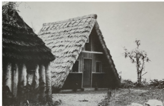
Figura 72: Casas rurais em Santana, sendo a da esquerda a cozinha. Evidencie-se o uso da palha nos telhados. A palha (colmo) usada nos telhados provinha da cevada (Freitas Branco, 2019) ou do trigo cuidadosamente ‘malhados’ com o mangual. (Ribeiro, O., 1985)
