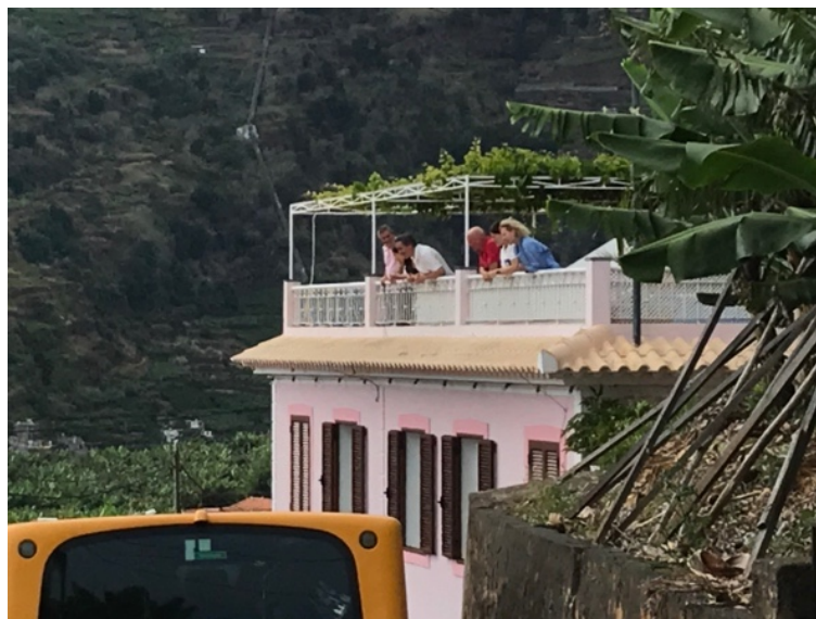
Figura 155: Janelas com os respetivos tapa-sóis (tipicamente são em madeira e de cor verde escuro). Neste caso, mesmo sem telhado de águas, o sombreamento da vinha no verão permite o controlo térmico no andar inferior, e no inverno contribui para o aquecimento da casa, uma vez que, sendo caduca, a vinha perde a folhagem e permite a incidência direta de radiação solar. No verão, a exposição indireta ao sol torna o terraço, ou quintal , um espaço sempre habitável. (Zona sul da ilha).
