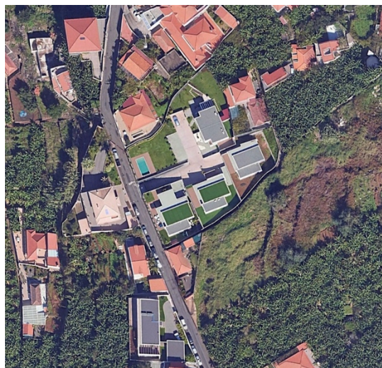
Figura 149: Mesma zona da figura anterior em 2023. Destaca-se o amplo espaço destinado apenas ao automóvel e a implantação desarticulada do empreendimento, tornada ainda mais evidente na piscina – um espaço sobrando, sem integração com o conjunto. (Google Earth Pro)
