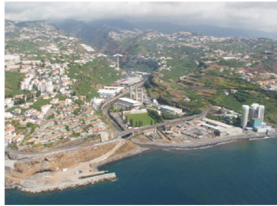
Figura 22: Ocupação do leito da Ribeira dos Socorridos (Abreu et al. , 2009)
