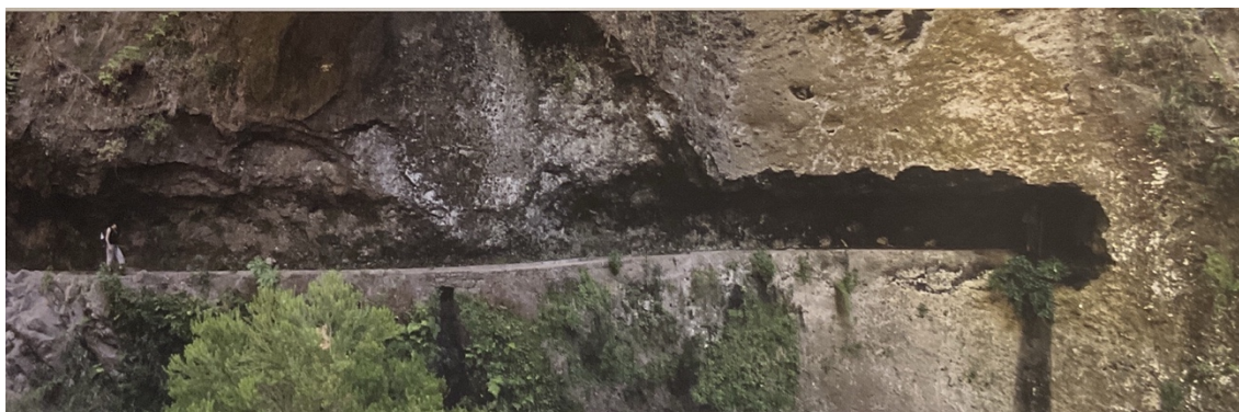
Figura 85: Parede vertical [ou ‘talude subvertical’ (Abreu et al. , 2007)] rasgada para passagem do canal de água . (Fotografia de ALMEIDA, J.P. Estruturas Pétreas no Território Madeirense , Revista Islenha , nº 53, 2013)
