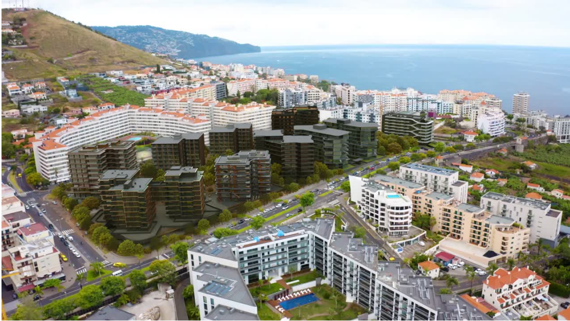
Figura 143: Empreendimento Madeira Dubai nos arredores do Funchal (zona da Ajuda) (imagem ilustrativa do projeto ainda em construção). Um amplo projeto no escasso solo edificável da ilha, mas não direcionado ao habitante madeirense. Exemplo de caos paisagístico e arquitetónico. A escala da intervenção, já em si problemática (como demonstram as edificações no entorno), associada à paleta cromática utilizada, introduz uma dissonância visual evidente na paisagem. A alta densidade de edificação e, sobretudo, a cor escura dos edifícios, denota a falta de atenção dada ao espaço verde, introduzindo nesse espaço coletivo a sensação de insegurança. O projeto não procurou adaptar-se ao local de inserção. Note-se, ainda, que o website da promotora imobiliária se apresenta, prioritariamente, em língua inglesa. ( Varino . https://www.varino.pt/en/dubai-madeira )
