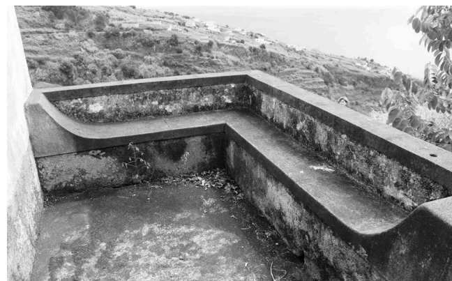
Figura 131: Os assentos das habitações vernaculares. Com a habitação reduzida aos compartimentos estritamente necessários – por razões sobretudo financeiras –, os assentos emergem como expressão arquitetónica da necessidade de sociabilidade quotidiana. Este espaço de sociabilidade configura-se como materialização de uma necessidade, como ato de alienação. (Pedro Gonçalves. Memória | Território | Desenho - Ilha da Madeira: Por uma arquitetura como paisagem . 2016. p. 131)
