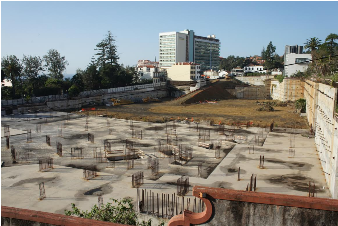
Figura 120: Terreno completamente vazio, sem preservação de qualquer edificação pré-existente. Ao fundo, à esquerda, observa-se a Rua Imperatriz Dona Amélia, onde foram posteriormente implantados edifícios em estilos do passado, sem reinterpretação crítica. ( Skyscrapercity . https://www.skyscrapercity.com/threads/madeira-hotel-savoy-palace.300002/page-11?nested_view=1&sortBy=oldest#replies )
