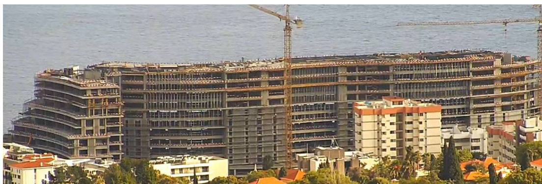
Figura 124: Fachada norte do Savoy Palace (em construção). A disposição do edifício favorece a vista para os que se alojam ou visitam o espaço por curtos períodos, em detrimento dos que habitam permanentemente a ilha – precisamente aqueles que mais necessitam de uma relação quotidiana com a paisagem que habitam e produzem. ( Skyscrapercity . https://www.skyscrapercity.com/threads/madeira-hotel-savoy-palace.300002/page-20?nested_view=1&sortby=oldest#replies )
