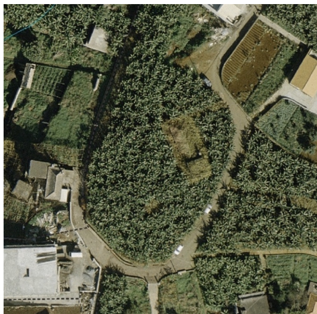
Figura 154: Casa em ruínas (2004) (construção em pedra) numa zona rural do Funchal. Junto à casa existia uma pequena edificação (à esquerda da casa, na parte inferior) de apoio agrícola, mas também destinado a cabras. O conjunto insere-se num bananal e a casa era circundada por vinha. ( Geofunchal . https://geofunchal-1-cmfunchal.hub.arcgis.com )
