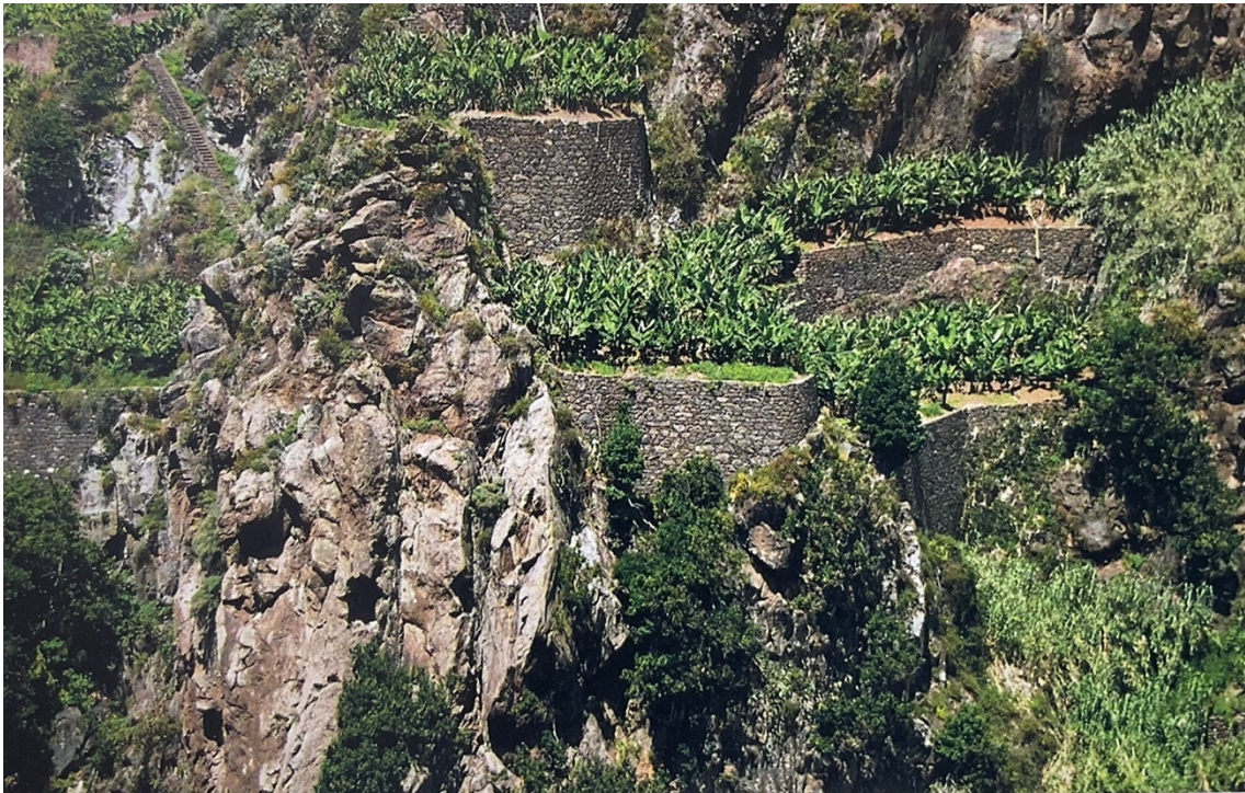
Figura 56: Conjunto de Poios (ALMEIDA, J.P. Estruturas Pétreas no Território Madeirense, Revista Islenha, nº 53, 2013)
