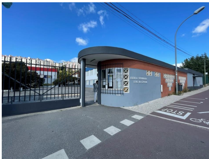
Figura 1. Entrada da Escola Secundária Leal da Câmara. Imagem de autoria própria.
