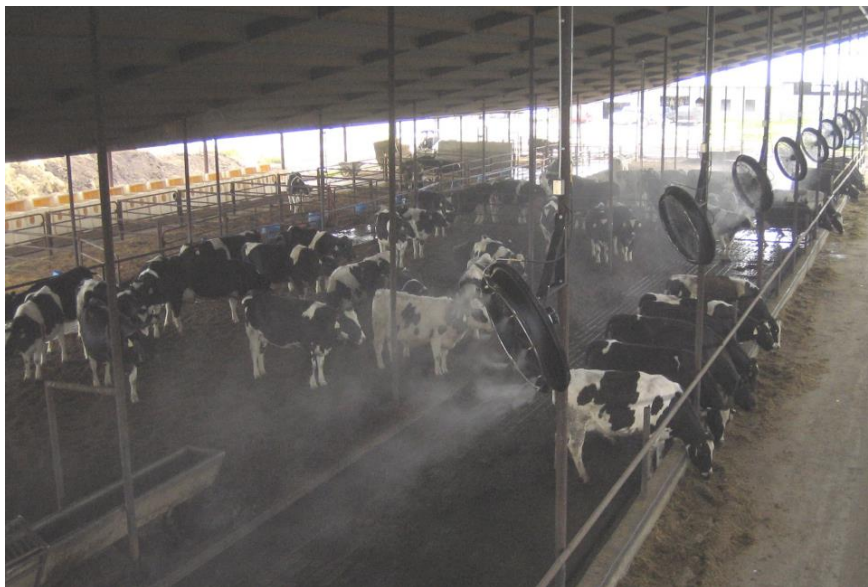
Figura 7 - Exemplo de um parque equipado com sistema de evaporação e ventoinhas (www.koolfog.com, 4/9/2015)
