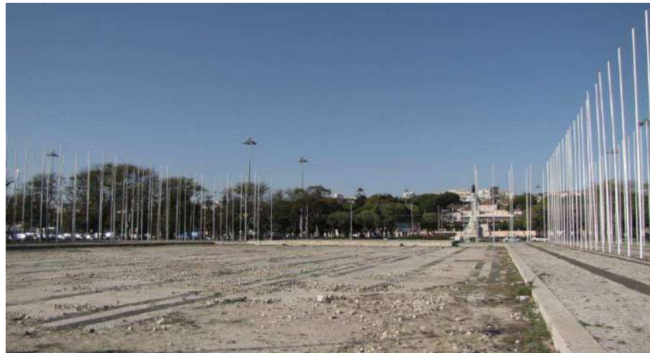
054 | Deterioração do Terreiro das Missas
