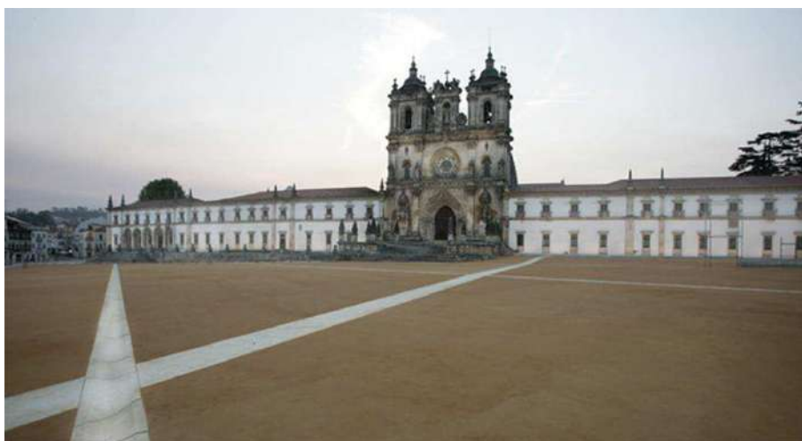
010 | Vista sobre a nova Praça 25 de Abril e a fachada do Mosteiro
