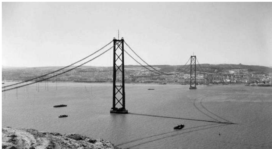
031 | Ponte 25 de Abril em construção
