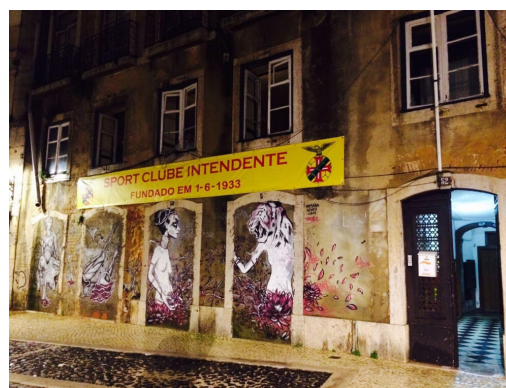
Fig. 105. Fotografia da fachada exterior e entrada do Sport Clube do Intendente, no Largo do Intendente.
