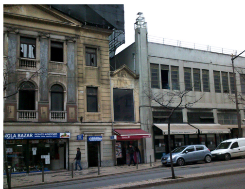
Fig. 36. Fotografia de edifícios devolutos e abandonados na Avenida Almirante Reis.
