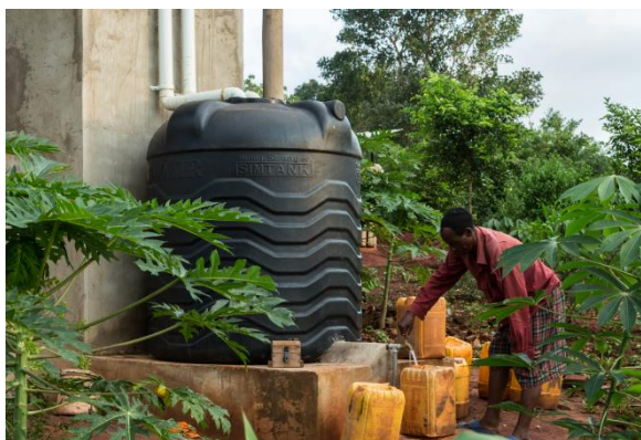
Figura 48. Reservatório de água exterior.
