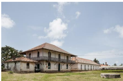
Figura 30. Casa Principal da Roça Ubo-Budo Praia.
