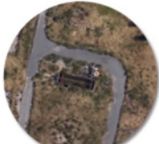
Ortofotomapa da estrutura metálica
