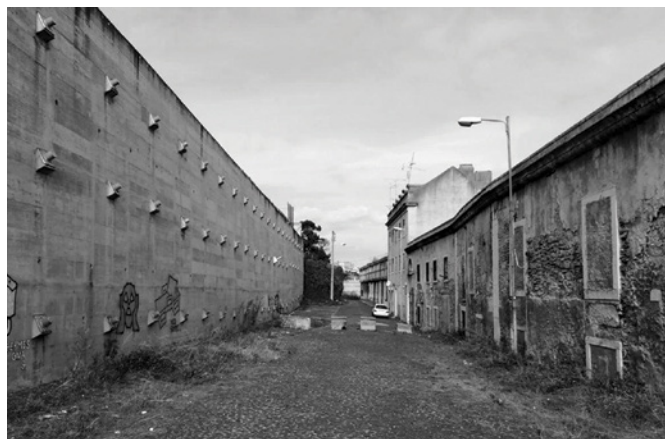
Estrada de Chelas, aqui ladeada pela Tinturaria Portugália e pelo muro de contenção de terras do Cemitério do Alto de S. João
